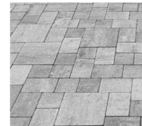
PAVIMENTO ADOQUÍN DE HORMIGÓN Dimensiones Ancho: 8-12cm Espesor: 6-12cm Peso: 3-7 Kg/pza Juntas: 1-5 mm
