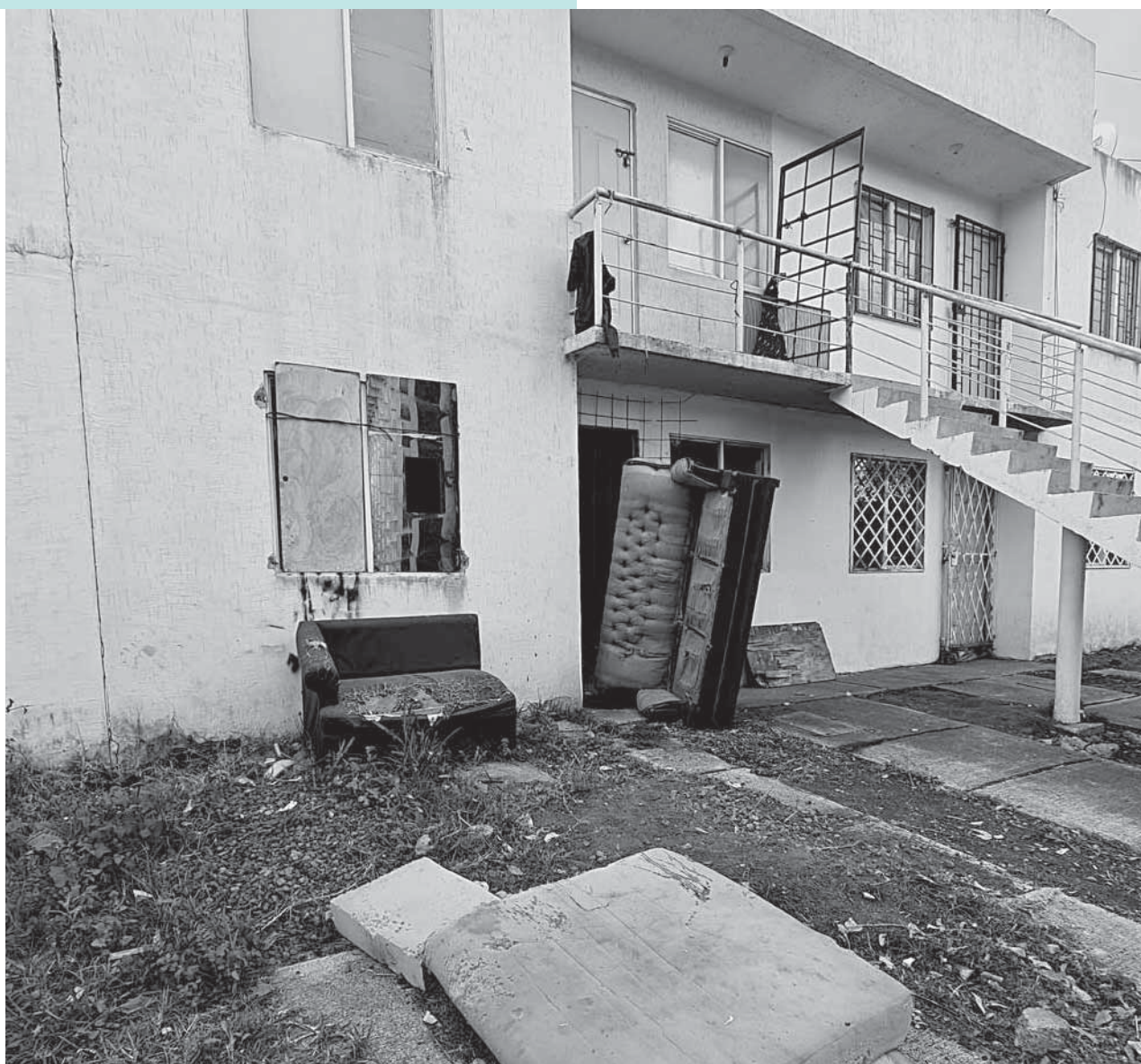
Fotografía 09. Viviendas abandonadas Villas del Pedregal. Morelia (De A. Noveltti). (2022, febrero).
