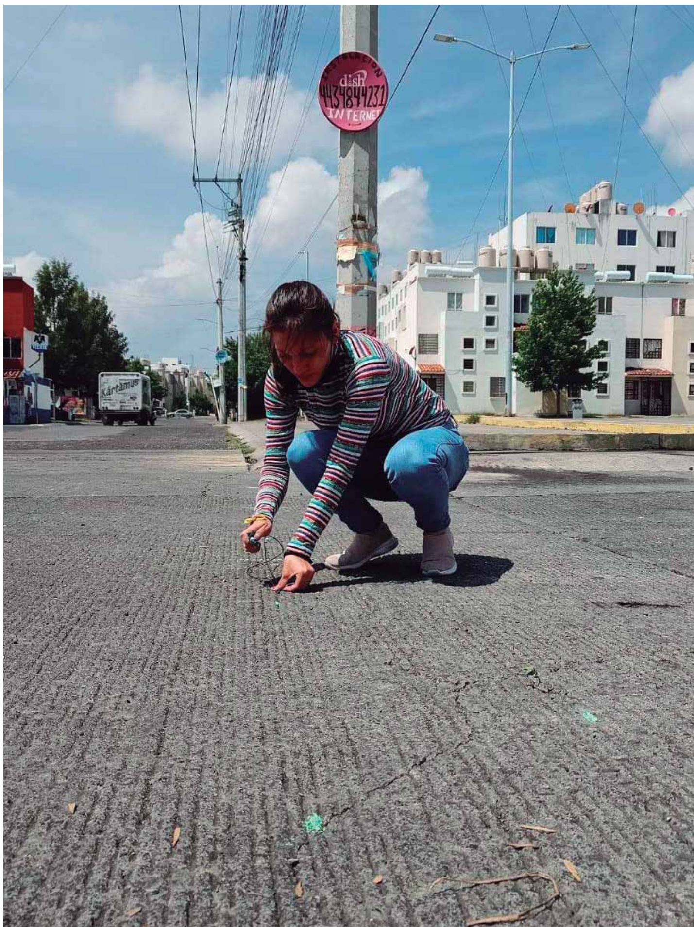
Fotografía 35. Calle antes de intervenir (De M. C. Chávez Rico). (2022, junio).
