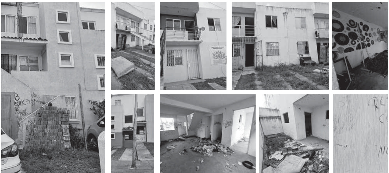
Fotografías 02. Viviendas abandonadas Villas del Pedregal. Morelia (De A. Noveltti). (2022, febrero).
