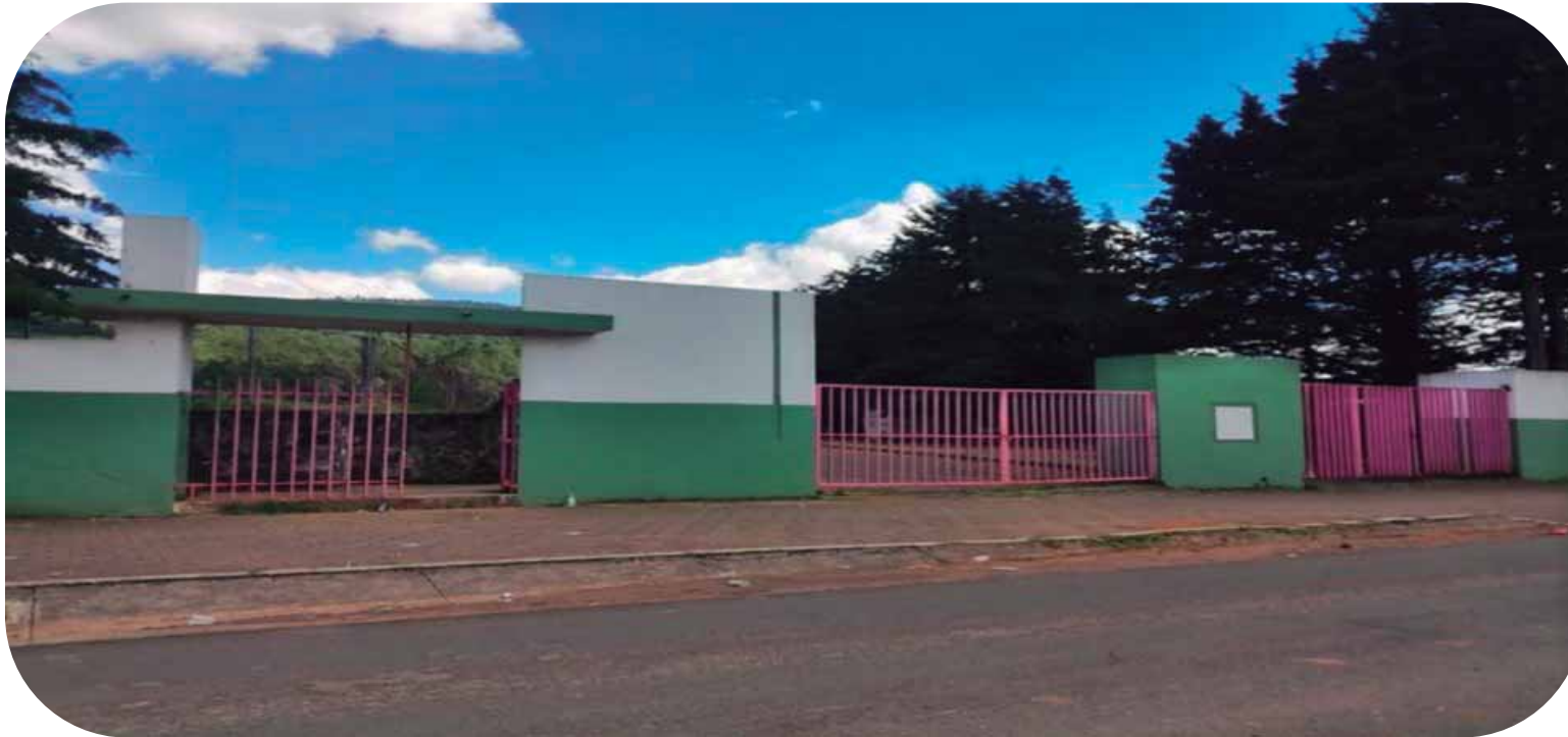
Imagen 31.- fachada de la unidad deportiva en estado actual. Fuente: propia
