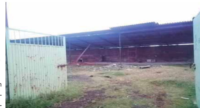
imagen 13.- antigua boquera municipal en estado actual. Fuente: Autor.
