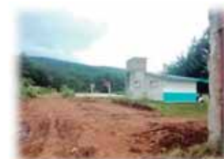
Imagen 4.- acceso secundario de la unidad deportiva municipal estado actual. Fuente: Autor.
