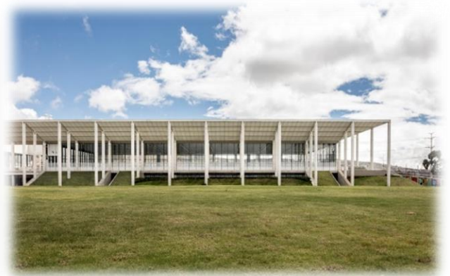
Imagen No. 4: Vista Lateral del Tunal
