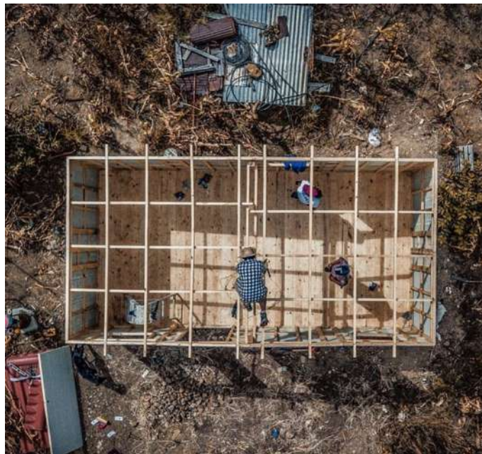
Obras ejecutadas por TECHO, Chile. Fuente: Instagram 2021.
