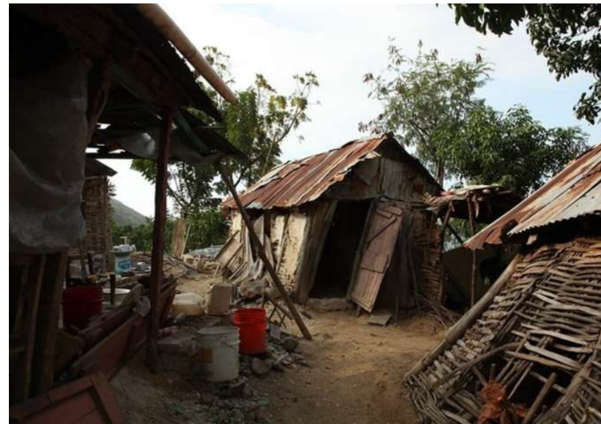
Obras ejecutadas por TECHO, Chile. Fuente: Instagram 2021.
