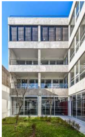
Fotografía 10. Fachada interior por jardín, Martín E. Gallino (archdaily).
