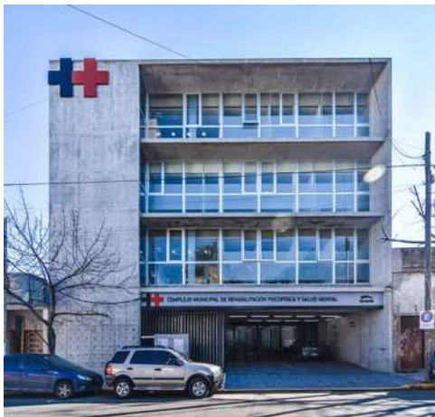
Fotografía 17. Fachada principal, Martín E. Gallino (archdaily).
