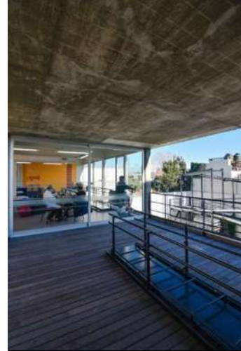
Fotografía 14. Pasillo frente al gimnasio, Martín E. Gallino (archdaily).
