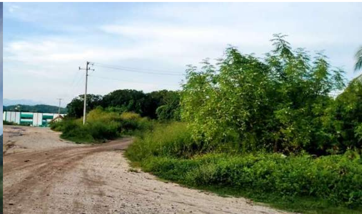
Fotografía 32. Simbolo con el número 2, Postes de Electricidad.
