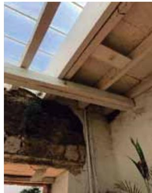
Ilustración 14. Paso de instalaciones eléctricas por techo de vigas, DERR, 2021.
