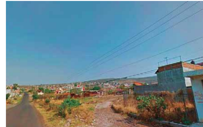
Ilustración 67: Av. Imperio Tarasco, Colonia San Isidro Itzicuaró, esta es una de las calles que aun no han sido pavimentadas. Fuente: Google Maps. Fotografía: DAJM.
