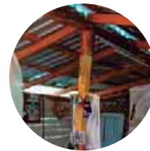
Estructura de madera
