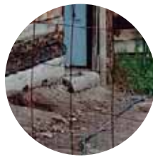
Construcción a nivel de suelo
