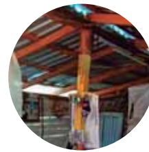
Estructura de madera
