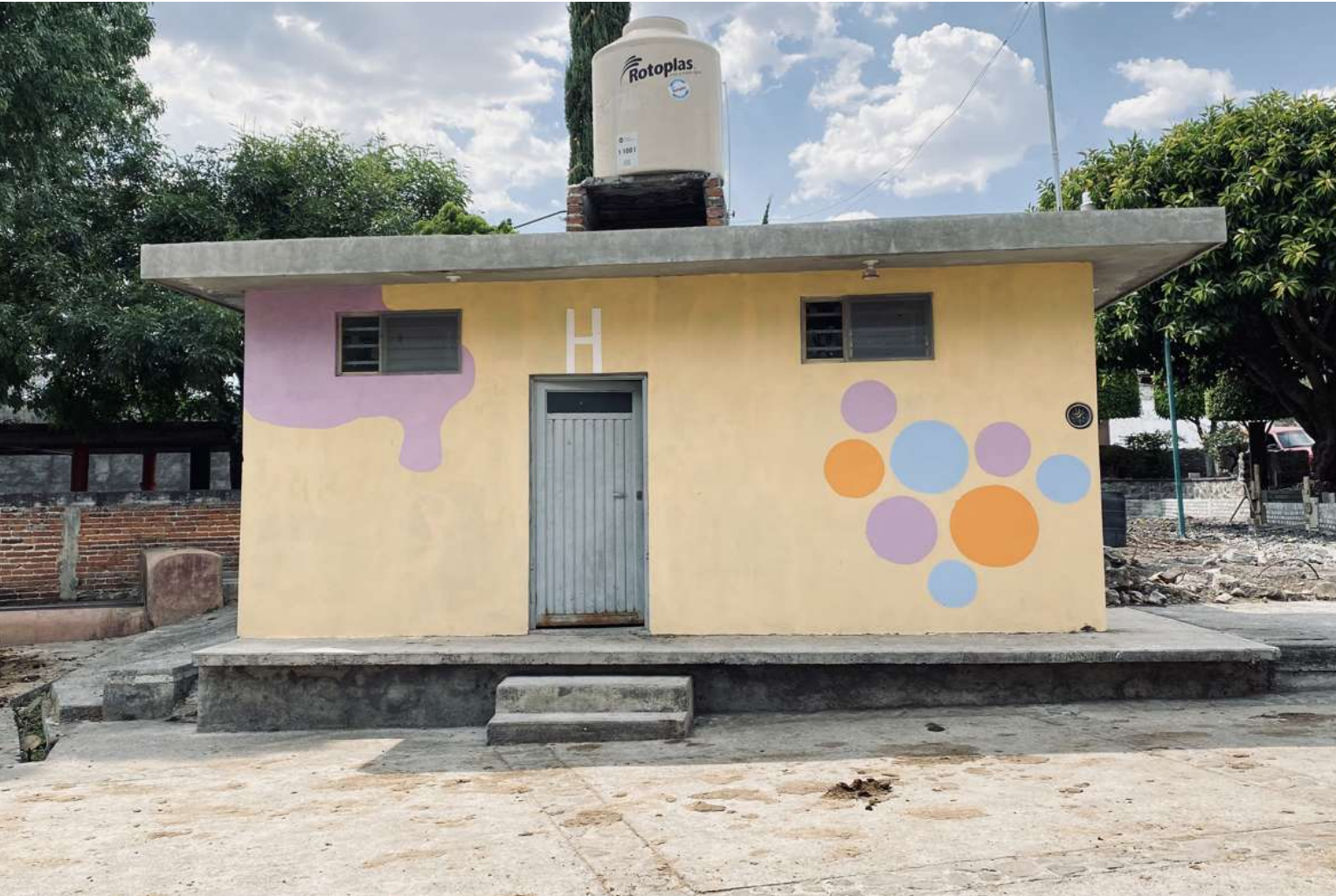
Figura 66. Terminación de mural. Fotografías tomadas en el lugar
