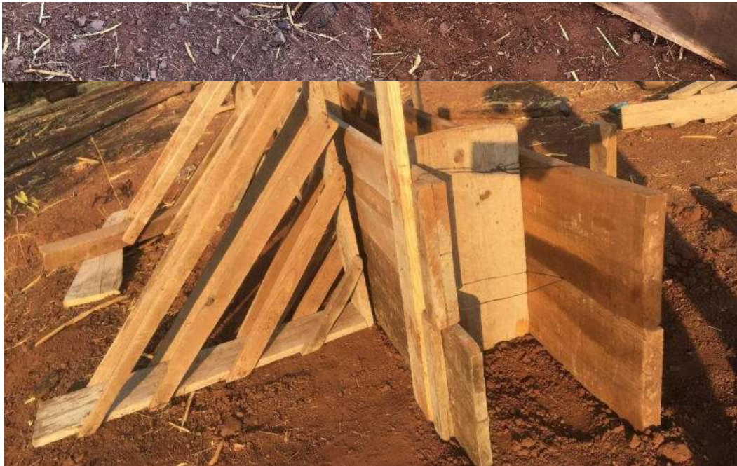
Ilustración 83 refuerzo y ajuste de tablonés. Fotografías de Liz VG.
