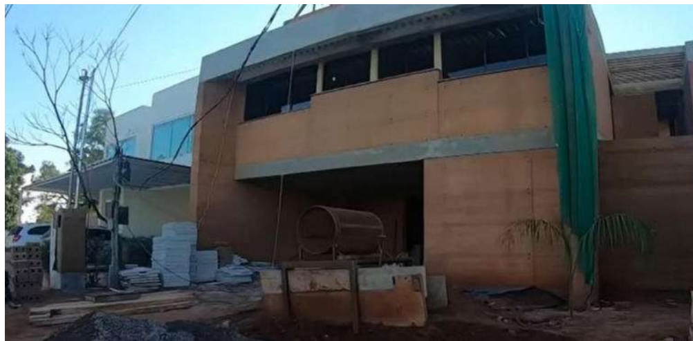
Ilustración 3 Vivienda de Tierra Compactada combinada con Acero y Concreto. Captura de pantalla de YouTube del Video Espacios & Tendencias de Paraquav (Tierra).
