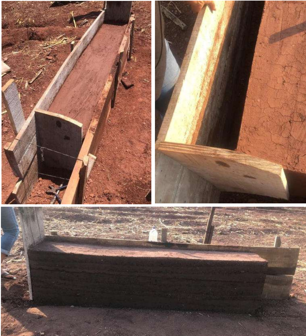
Ilustración 87 Experimentación, desencofrado, fotos de Liz VG.
