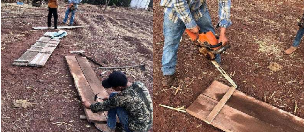
Ilustración 83 refuerzo y ajuste de tablonés. Fotografías de Liz VG.
