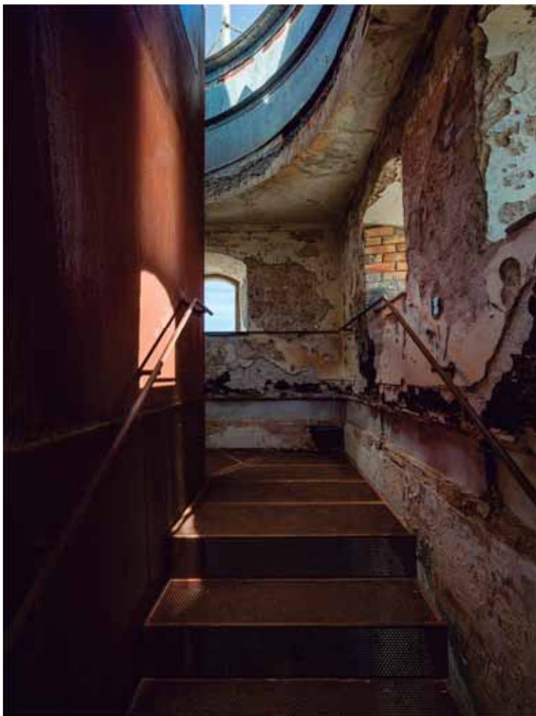
Figura 71: Fotografía Hampus Per Berndtson, escalera interior Faro Rubjerg Knude (2016)
