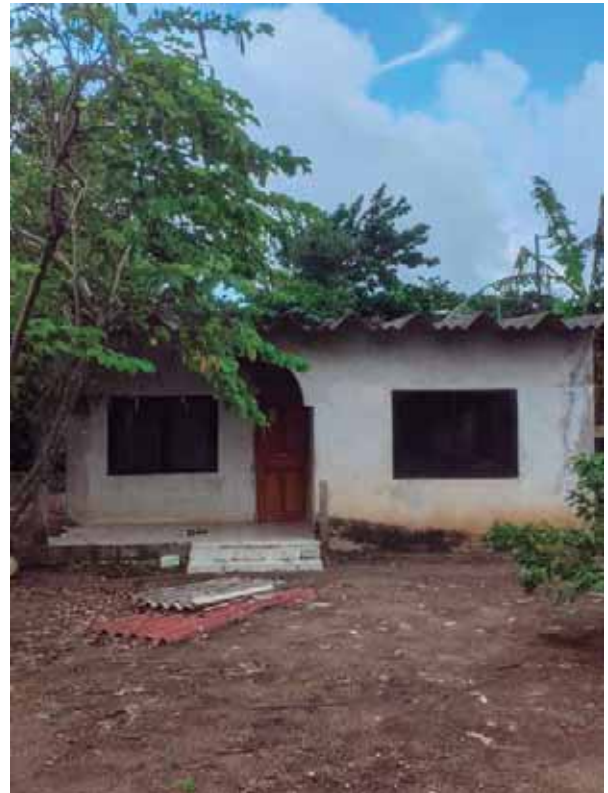
Figura 47: Fotografía propia de una casa común en la comunidad de Arroyo de Liza. (2021)
