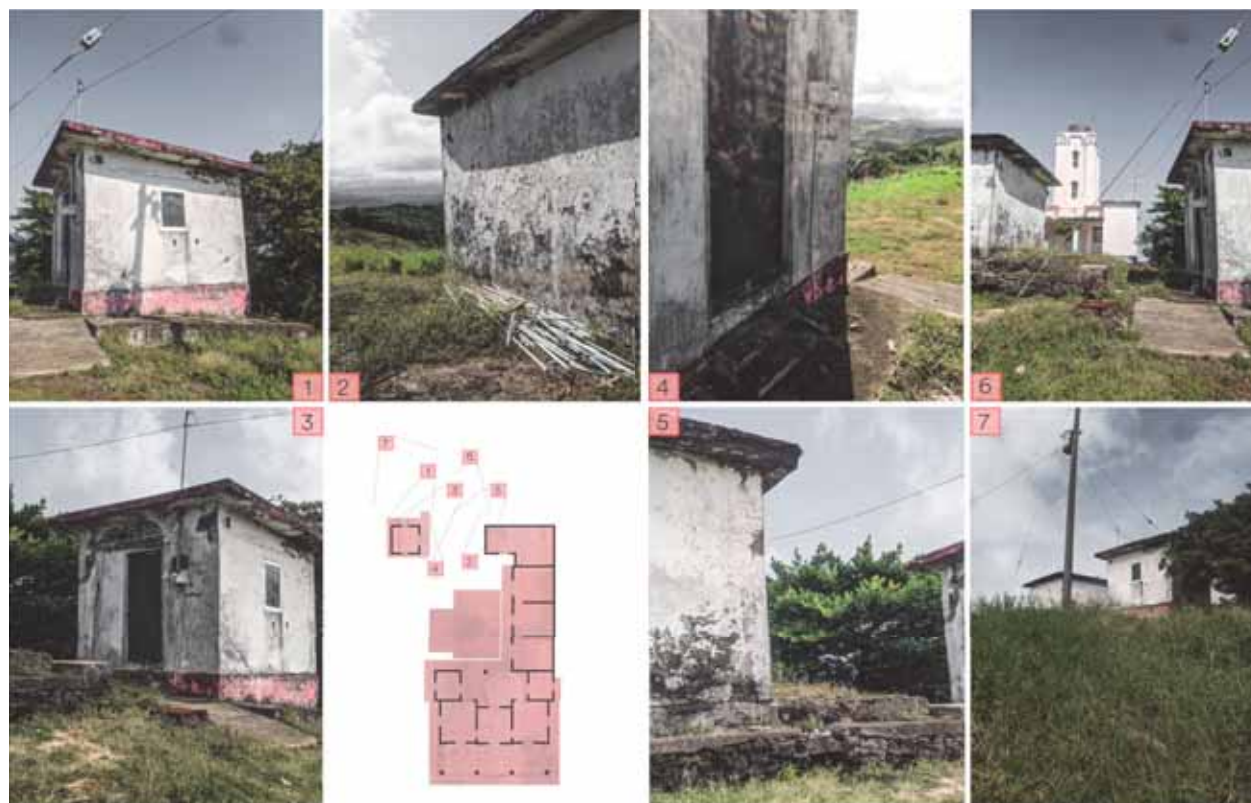
Figura 29: Collage de levantamiento fotográfico del faro de Roca Partida (2021)
