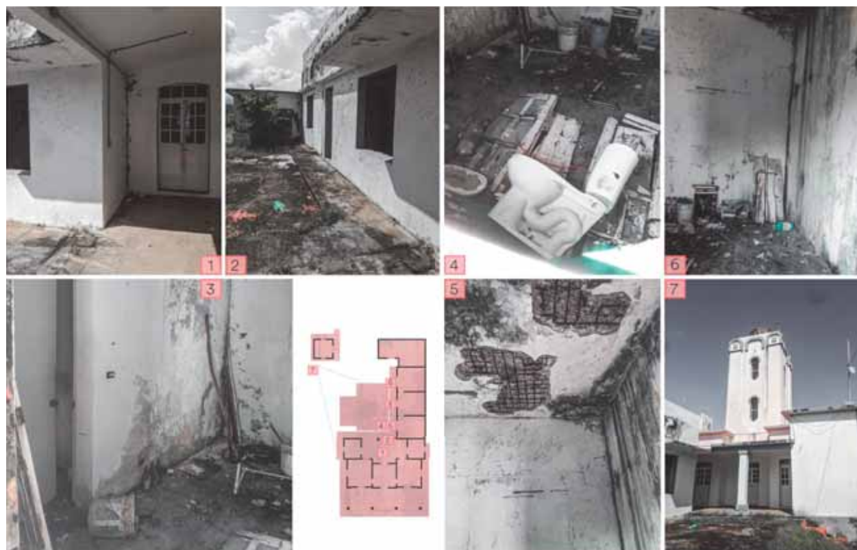
Figura 25: Collage de levantamiento fotográfico del faro de Roca Partida (2021)
