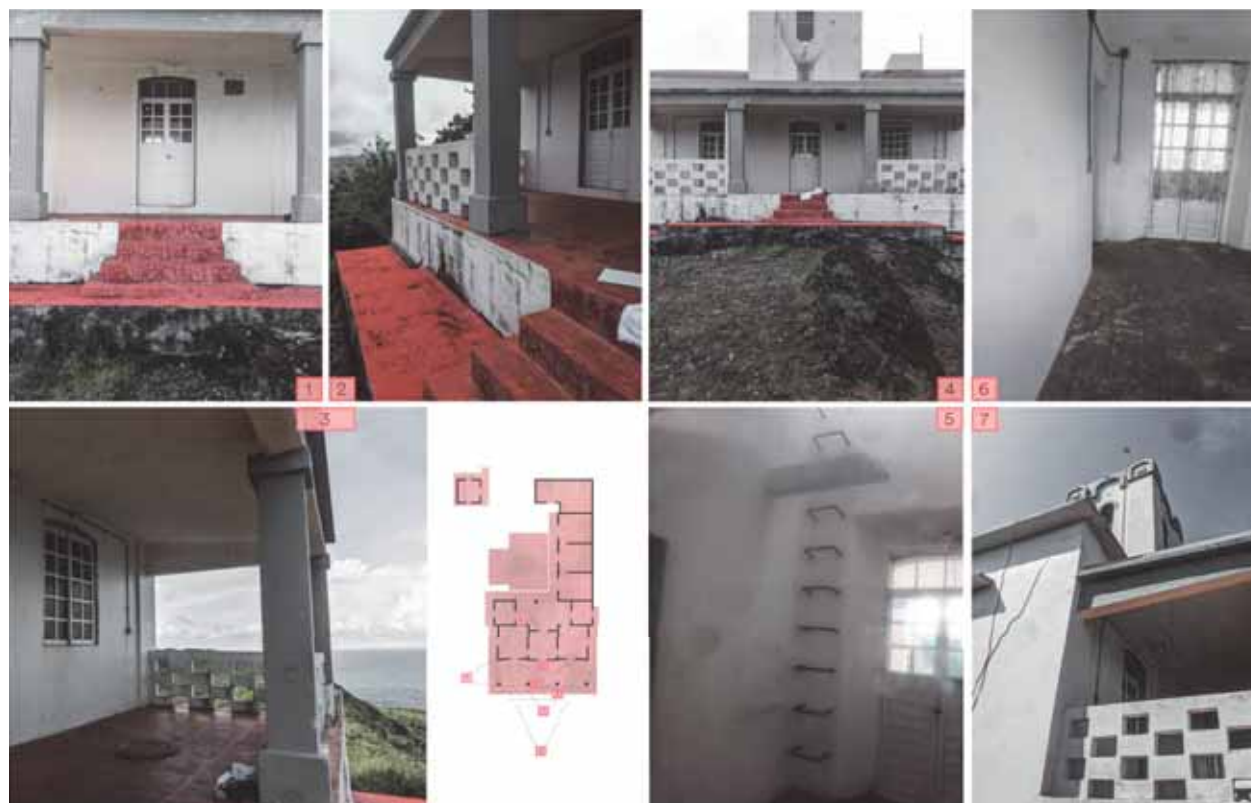
Figura 23: Collage de levantamiento fotográfico del faro de Roca Partida (2021)
