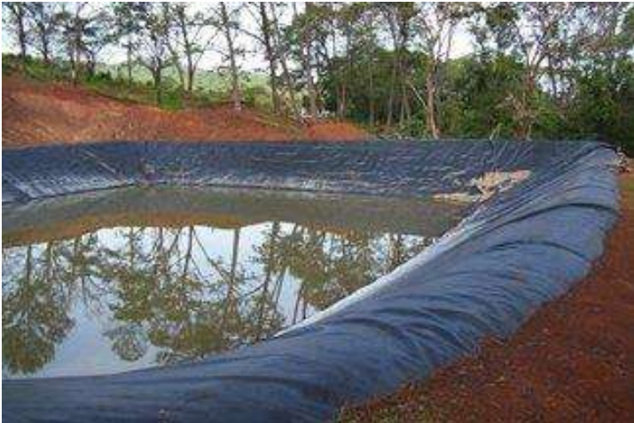
Fig. 40.0. Ejemplo de olla de agua. Fuente: https://www.geosai.com/olla-de-agua/
