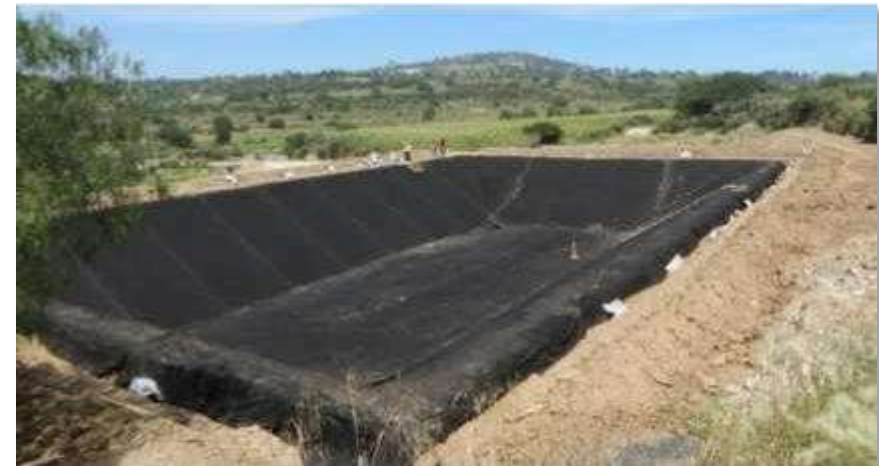
Fig. 44.0. Geotextil unido mediante calor (con pistola de aire caliente). Fuente: Ollas de agua, jagüeyes, cajas de agua o aljibes (2da ed.) (slideshare.net)
