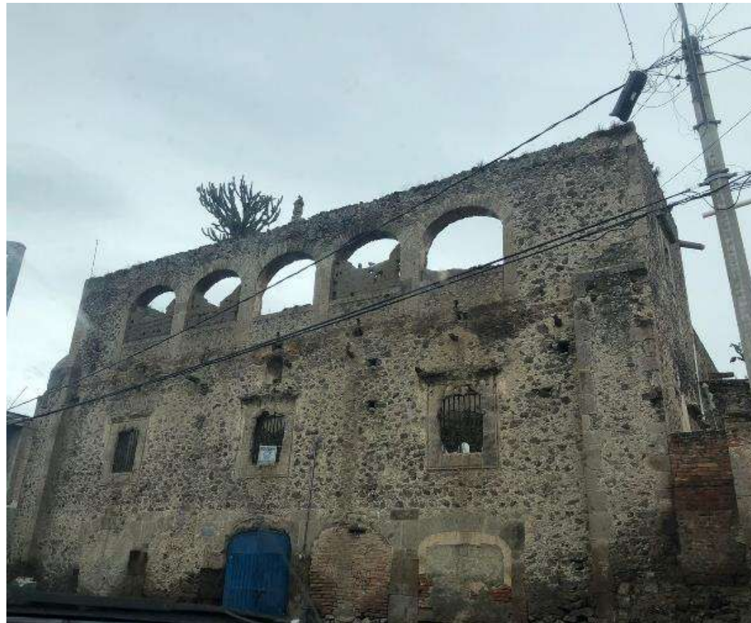
Figura 26. Cableado para alumbrado público. Fuente: Elaboración propia.
