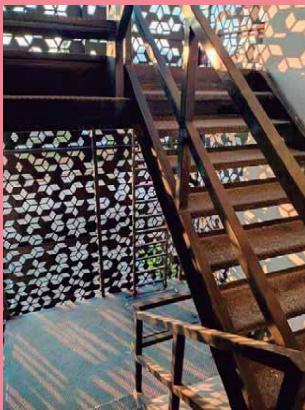
Ilustración 30 Escaleras de emergencia. Fotografía de autor.
