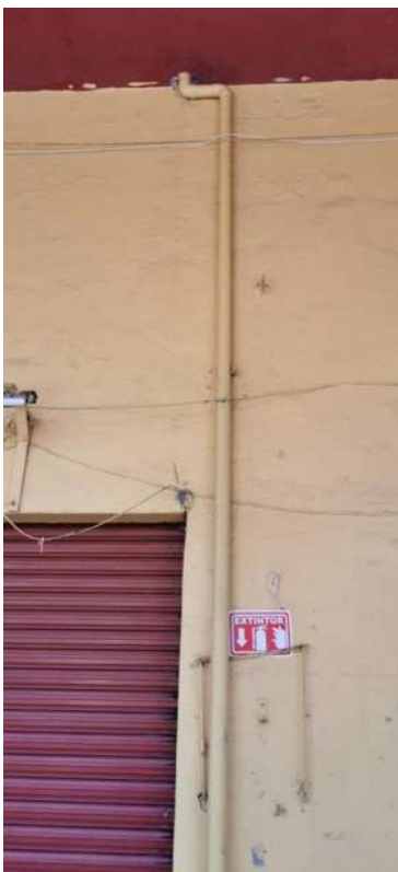
Fig. No 42 Adecuación de tuberías para bajar aguas pluviales.
