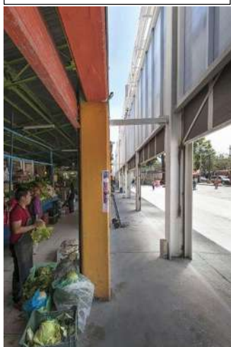
Fig. No 25 Fachada mercado la Providencia
