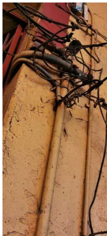
Fig. No 43 Adecuación de instalaciones eléctricas.
