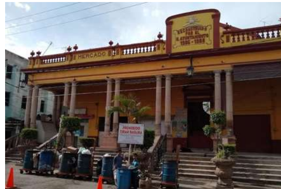
Figura No. 1 Fachada sur del Mercado Hidalgo
