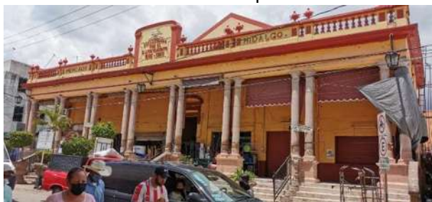
Fig. No 7 Fachada Principal Sur
