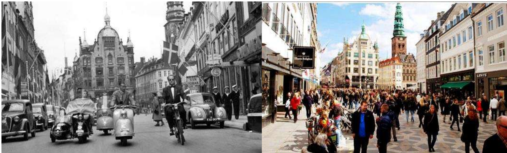
Ilustración 35. Strøget, el peatonalizado eje principal de la ciudad antigua de Copenhague, antes y después de la transformación Fuente (Blasco, 2015)
