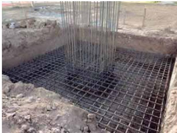
Figura 84. Sistema de zapatas aisladas.
