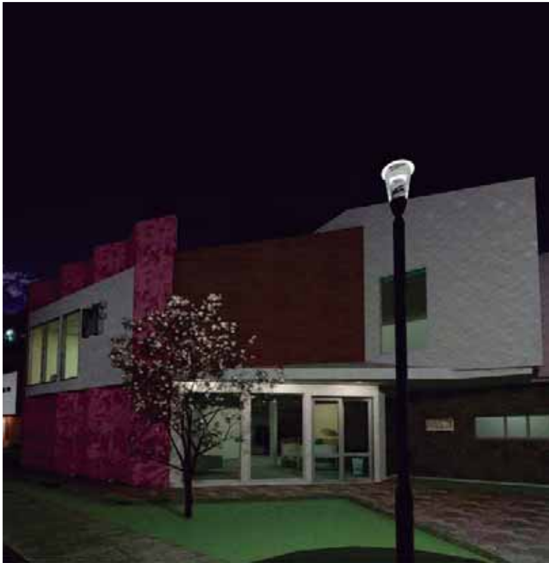
VISTA EXTERIOR ACCESO PRINCIPAL
