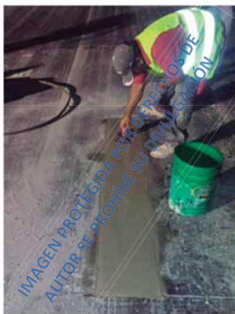
Ilustración 22. Llano de concreto Dinamix FR en desconchamientos para el aeropuerto, archivo personal T.Y.L.L.
