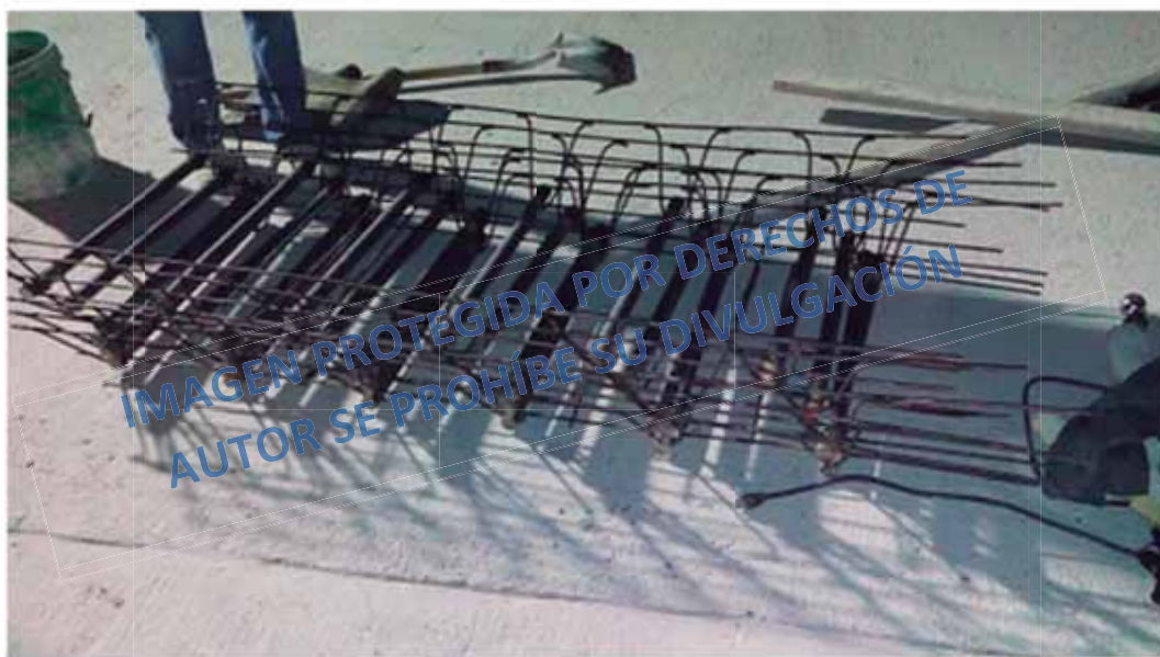
Ilustración 17. Suministro de canastillas de acero para junta de control para losas a sustituir en rodaje del aeropuerto, archivo personal T.Y.L.L.
