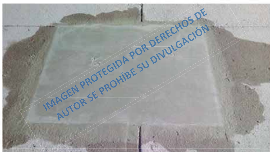
Ilustración 23. Colocación de marca del año en desconchamientos para el aeropuerto, archivo personal T.Y.L.L.
