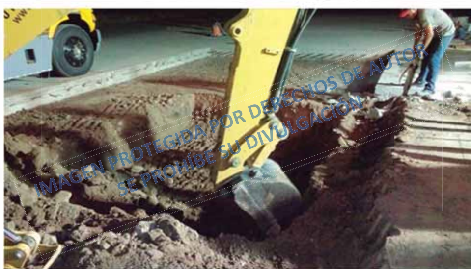
Ilustración 10. Corte de material de sub-base a mayor profundidad de losas a sustituir en rodaje del aeropuerto, archivo personal T.Y.L.L.
