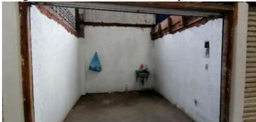
Imagen 74. Foto Urbana tomada por ESHT. de los Locales del Mercado en su estado actual. 77
