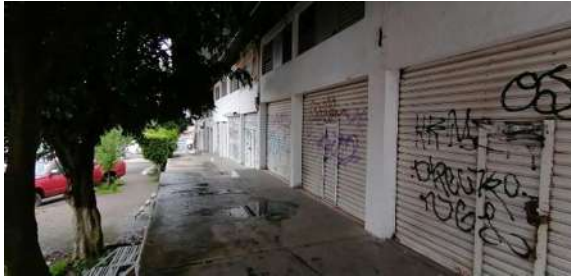
Imagen 71. Foto Urbana tomada por ESHT de la circulación exterior del Mercado en su estado actual. 74
