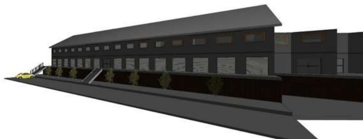
Imagen 81. Estado Actual del Inmueble. 81
