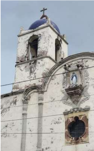
Estado actual desprendimiento de Pintura en Torre Menor, Septiembre 2021 Fotografía Lizbeth Pérez
