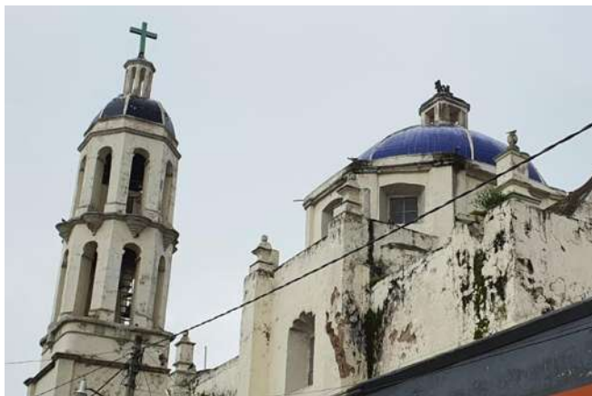
Estado actual de la fachada Norte, Septiembre 2021 Fotografía Lizbeth Pérez
