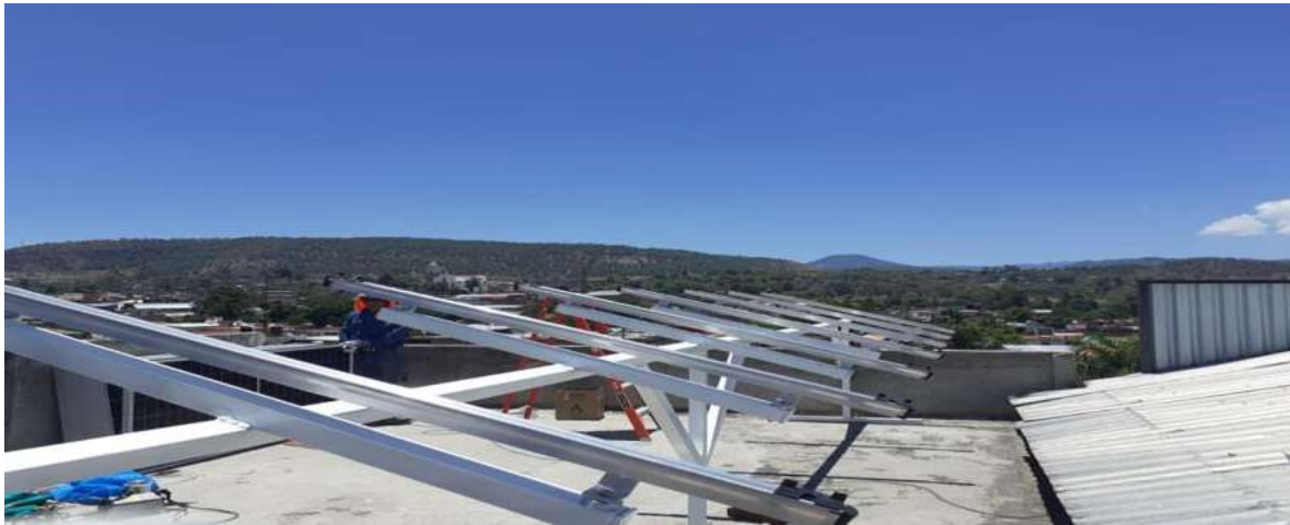
Figura 4.14 Montaje de la Estructura y Rieles (Fuente: Elaboración Propia).
