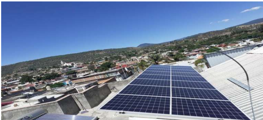
Figura 4.15 Vista de los 8 Paneles Colocados (Fuente: elaboración Propia).
