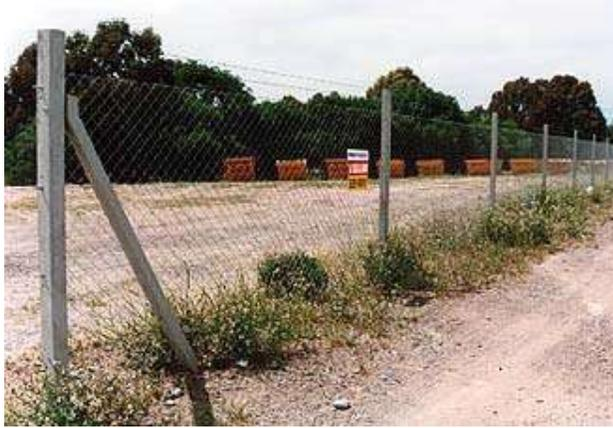
**Figura 24.** Soporte de malla con postes e concreto
