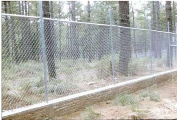
**Figura 15.** Malla ciclónica con base de concreto para prevenir el paso a depredadores.
