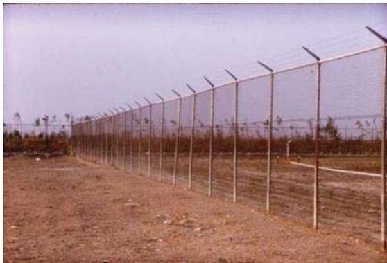
**Figura 25.** Postes de metal galvanizado
