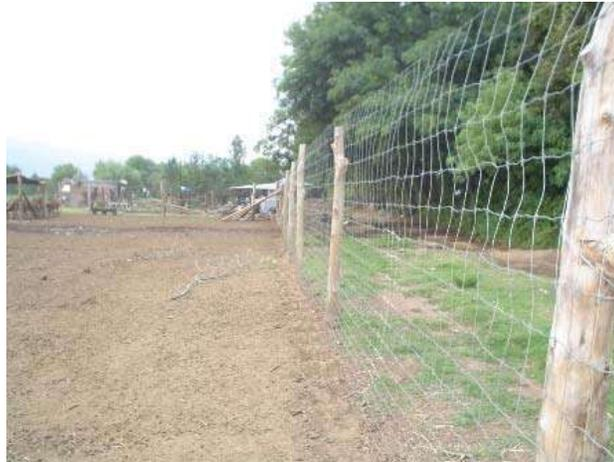
**Figura 23.** Los postes que sujetan la malla deben de ir por el exterior
