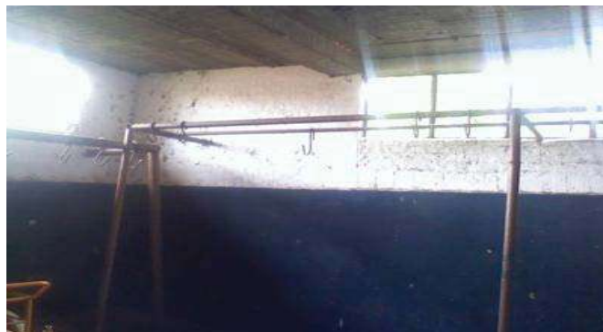
Imagen que nos muestra la falta de rieles de suspensión en (Penjamillo)
