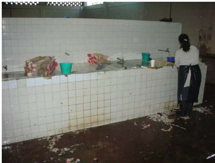
Imagen que muestra el área para el lavado de vísceras, en el rastro municipal de Peribán.
