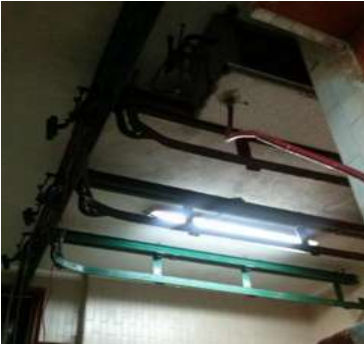
Fig.31 como se encuentran los rieles en el rastro de la posta los cuales están dentro de lo que nos indica la norma.
