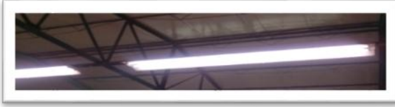
Fig. 26 Ventilación en el rastro de la posta zootécnica.
