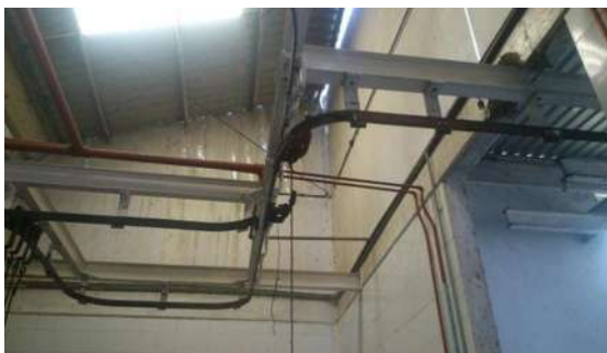
Fig. 51 riel de suspension
