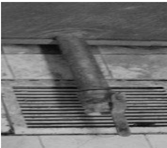
Fig.37 Área de drenaje adecuado.
