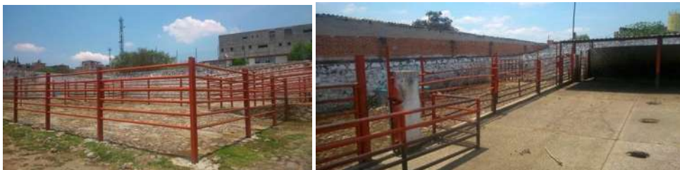
Fig.16 Donde se realiza la inspección.
