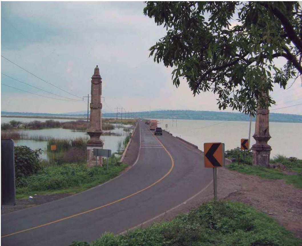
VISTA DE LA CALZADA DEL LAGO DE CUITZEO, IMPORTANTE VÍA DE COMUNICACIÓN.
