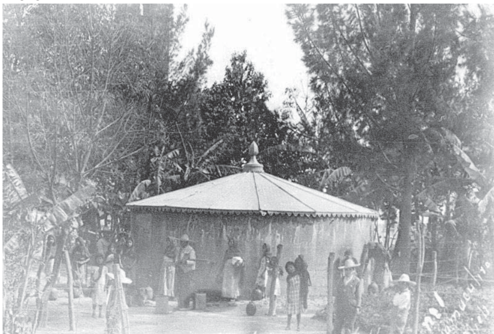
Pila de agua 154
