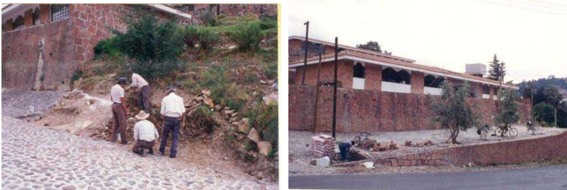
Empedrado de acceso a la preparatoria autorizado por el Gobierno del Estado y ejecutado por la Secretaria de Obras Públicas en la dirección del ingeniero Froilán Vargas. Fotos propiedad Arturo Berrios Guerrero.
