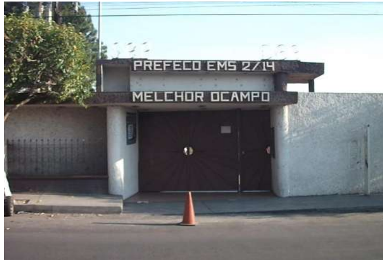
Puerta de Acceso principal a la PREFECO "Melchor Ocampo"
