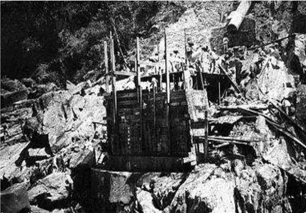
En el fondo de la barranca del marqués, construyendo la mampostería que dio soporte a los tubos de los sifones. Fuente: www.miarroba.es
