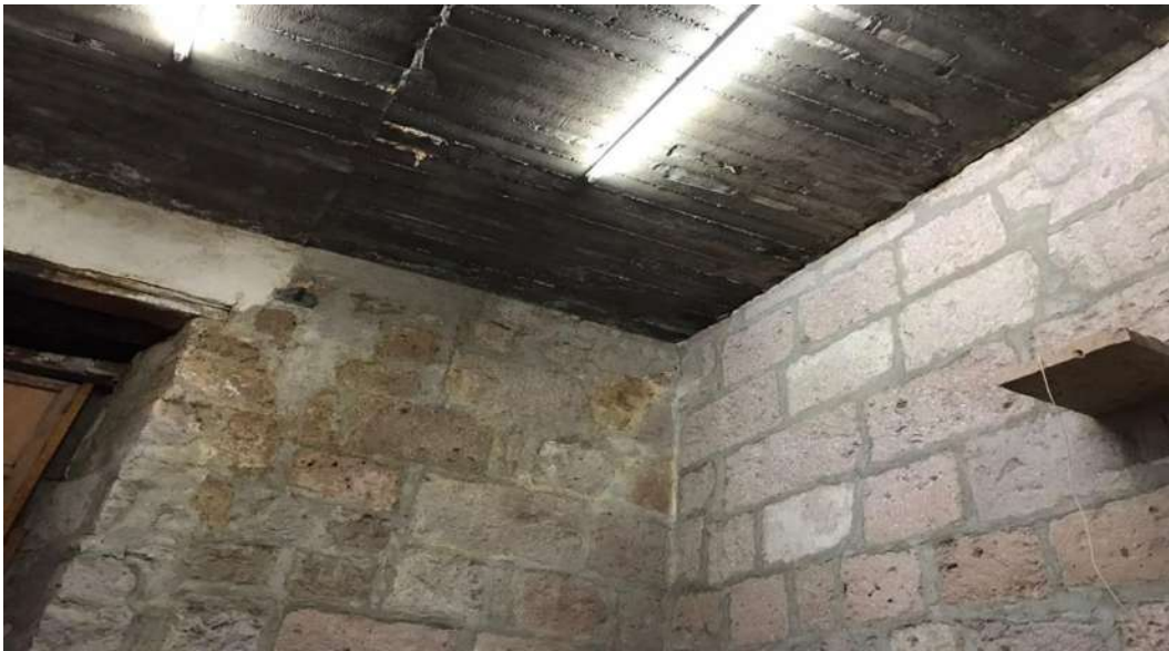
Imagen 12: Fotografía actual del techo donde se encuentran resguardadas las cajas del AHPMM. Se puede ver cierto tipo de humedad reflejado en la pared y en el techo.
