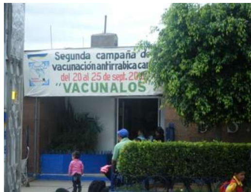
Fig. 19 En esta imagen se ve el centro de salud público de Puruándiro Michoacán
