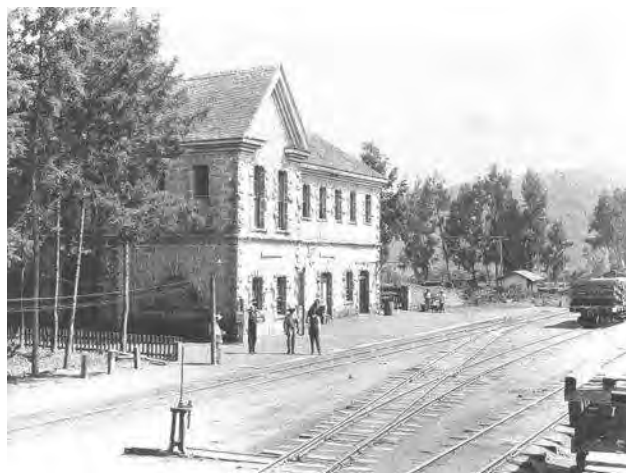
Imagen 23.- Estación del ferrocarril
