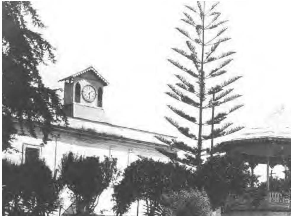
Imagen 13.- Edificio del primer ayuntamiento de Zitácuaro
