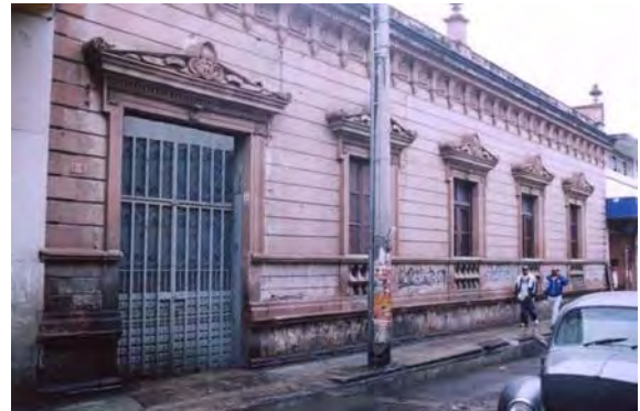
Imagen 44.- Edificio del caso 2
