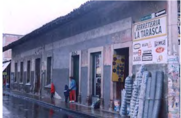
Imagen 42.- Edificio del caso 1
