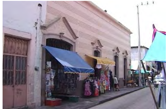
Imagen 48.- Edificio caso 4 Foto: Luis Mercado Sánchez
