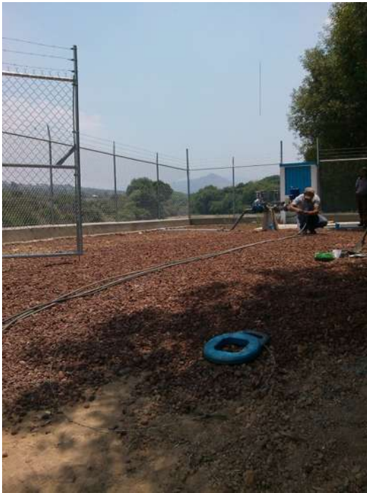
Instalación de los cables de energía eléctrica de la bomba sumergible del pozo
