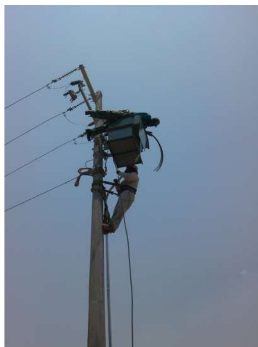
Ampliación de la red de energía eléctrica y transformador.
