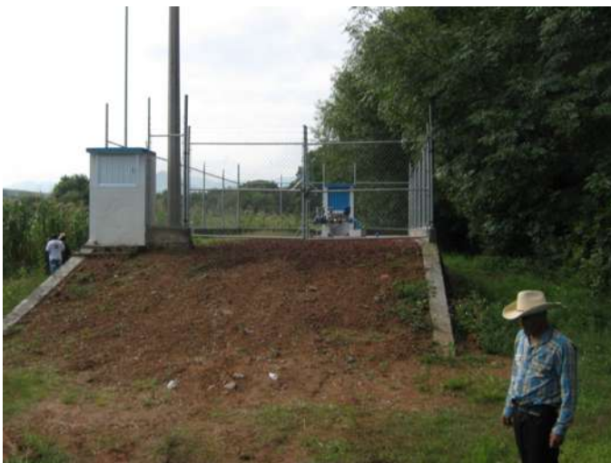
Vista general de la fuente de abastecimiento, con malla ciclónica
