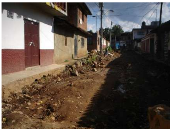
Fotografía 5, de proyecto de obra pública, archivo personal.
