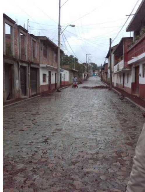
Fotografía 8, de proyecto de obra pública, archivo personal.
