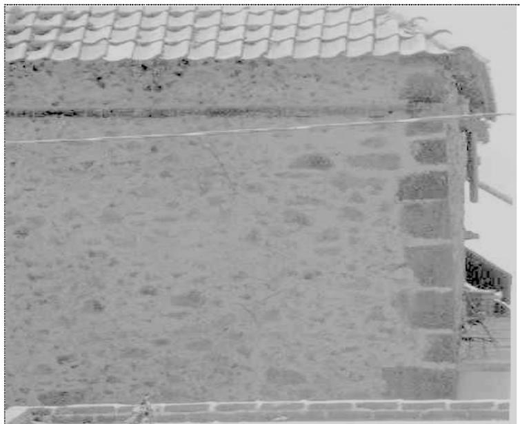
Foto No. 16 Sistema constructivo a base de piedra aglutinada con arcilla característico de la Sierra Purépecha
