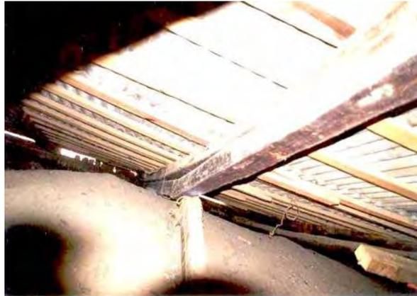
Foto 15 Interior de la estructura de madera con una notable deformación.
