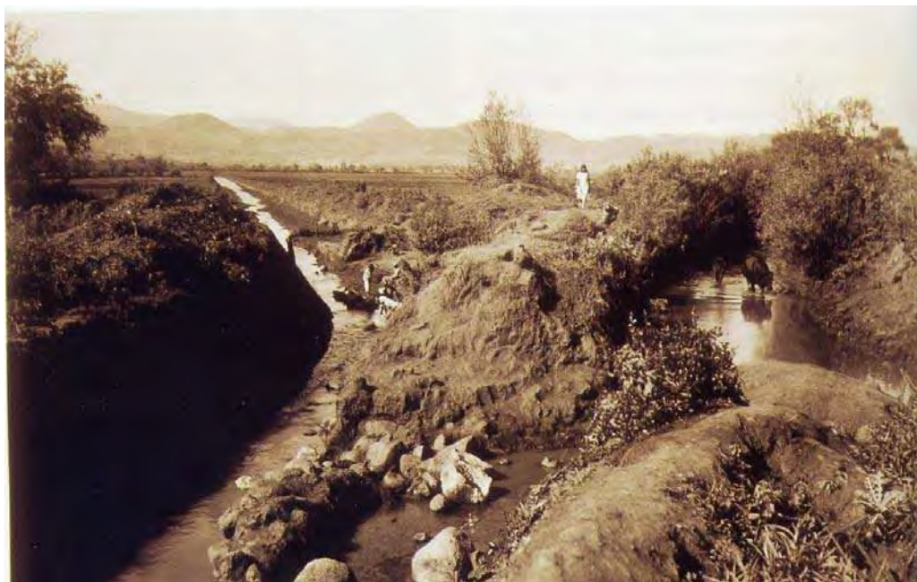
Imagen 18. Canales de aguas negras uniéndose para llegar a los ríos de Morelia
