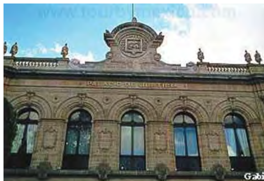
Fig. 13.- Casas Consistoriales.- Construcción digna de ostentar el principio de autoridad y decoro por el poder civil. Residencia y habitación del Alcalde Mayor. (hoy Palacio de Justicia) Foto: www.tourbymexico-com
