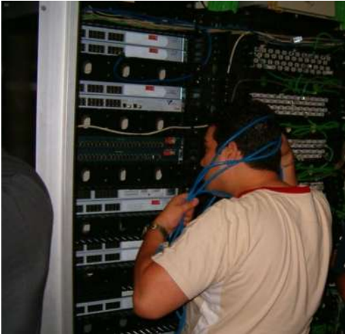
Figura 4.16 instalando cableado para servidores
