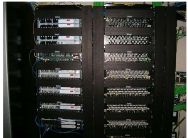
Vista del panel de parcheo y switches
