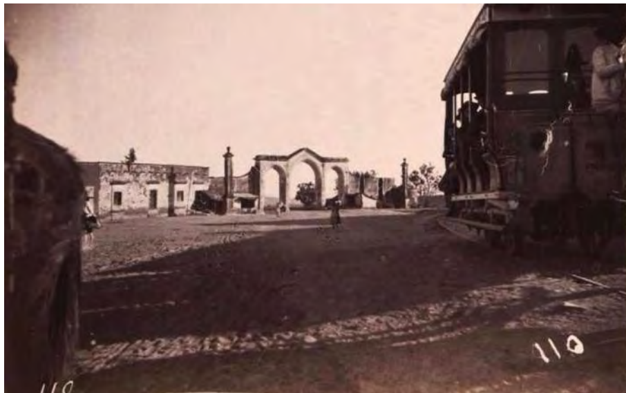
Fig. 6. Otro aspecto de la garita. Foto del grupo “Historia de Guadalajara” imagen publicada en su muro de Facebook. S.f.
