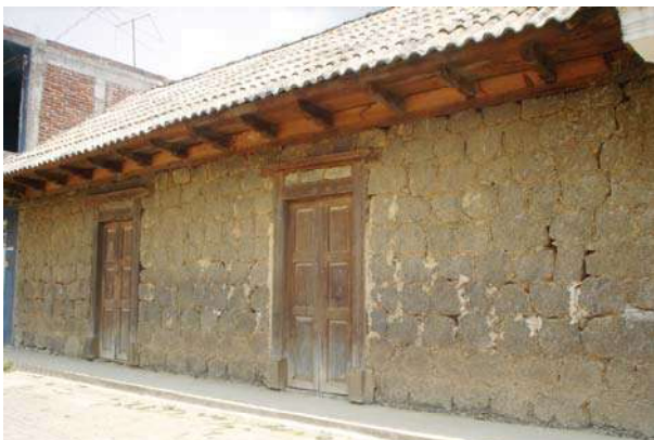
Fig. 178.-Casa con muros de piedra y lodo en Nurío, como las que debió haber en el siglo XVII en los asentamientos de la región.
