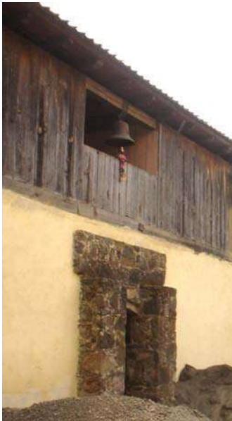
Fig. 210.-El campanario del hospital de Sevina.
