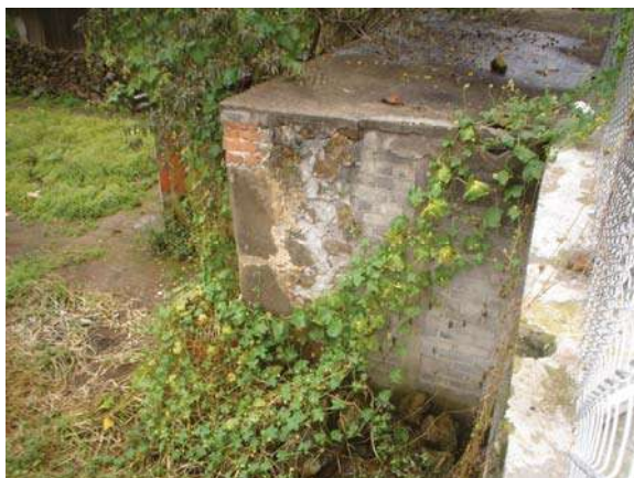
Fig. 67.-De la antigua capilla sólo quedaron algunos fragmentos de su ábside, ya que fueron reutilizados en la construcción de la escuela primaria en el siglo XX.
