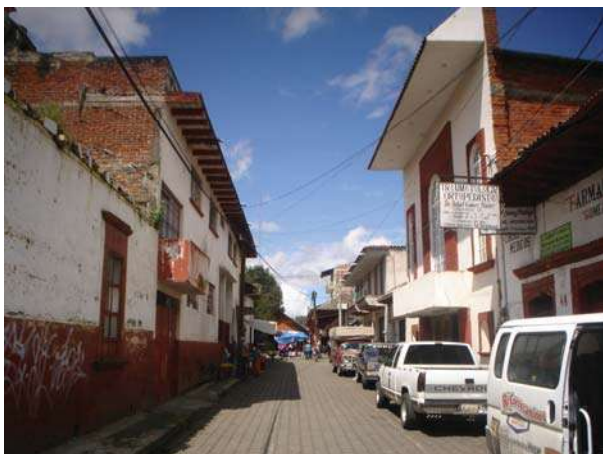
Fig. 21.-Hasta 1940 funcionó el hospital en donde hoy está un cine abandonado y unos locales comerciales (construcciones de la izquierda).
