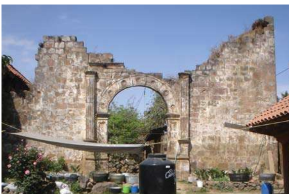
Fig. 201.-La fachada de la capilla de Santa Cruz Tanaco, fechada en 1683.
