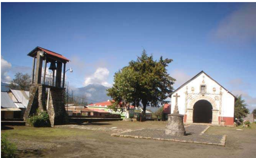
Fig. 30.-El hospital con su patio, cruz central, pórtico-campanario y la capilla.
