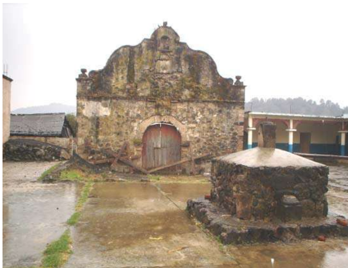
Fig. 153.-En la fachada del actual templo en ruinas se conservaron algunos elementos que seguramente pertenecieron a un antiguo edificio, como sus
