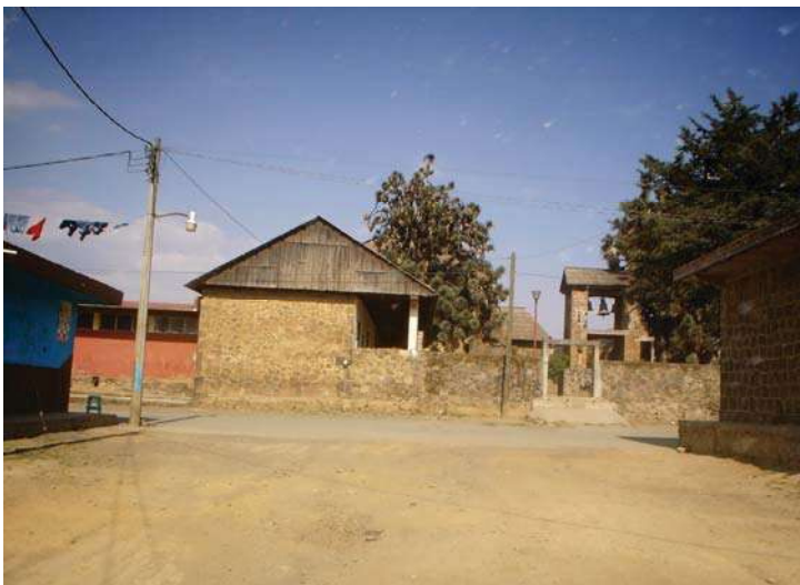
Fig. 38.-En el sitio que guarda hasta la actualidad se ubicó muy probablemente el hospital de Nurío desde el siglo XVI.
