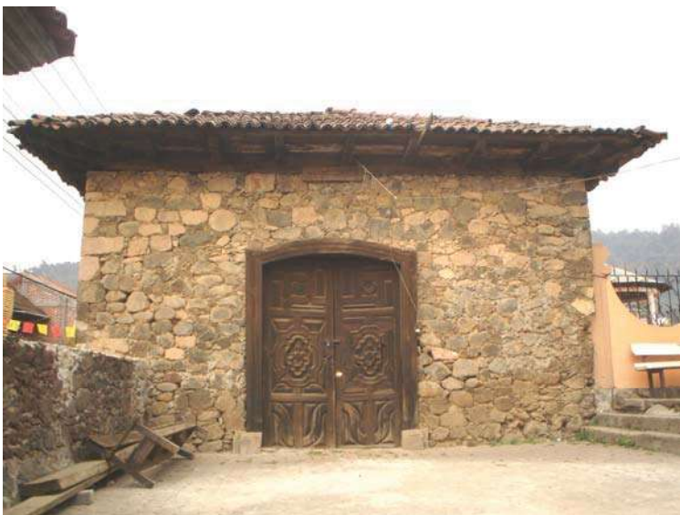
Fig.- 133.-La fachada principal de la capilla.
