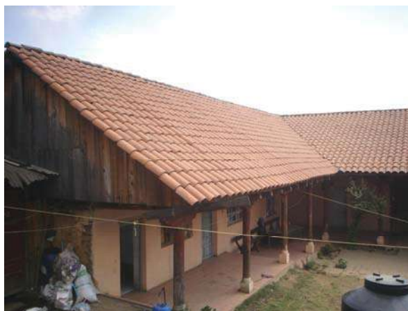
Fig. 88.-En 1955 reconstruyen las antiguas habitaciones del hospital y regresan a vivir en ellas.
