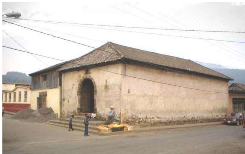
Fig. 105.-La capilla vista desde el poniente. Con su fachada principal hacia la calle, como consecuencia de una alteración en su disposición original.
