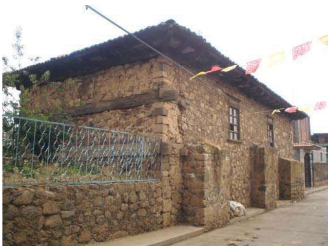
Fig. 131.-La capilla ha tenido varias intervenciones materiales.
