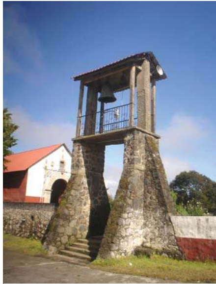
Fig. 209.-El pórtico-campanario del templo-hospital de Pomacuarán.
