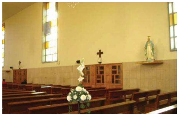
Imagen 3.24. Bocinas en muro. Parroquia de Santiago Apóstol, 1978-1981
