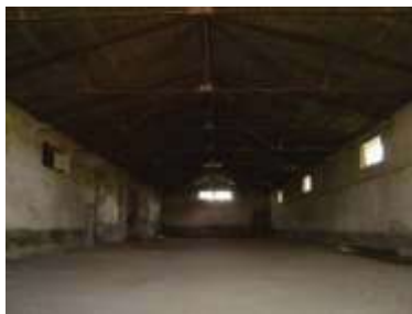
Figura 42. Vista de la troje que se utiliza como estacionamiento.
