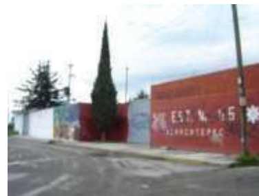
Figura 8. Vista de la fachada de la Escuela Secundaria.
