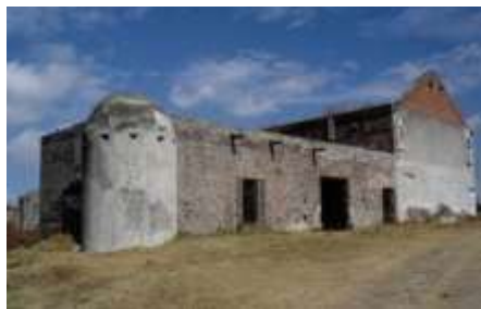
Figura 36. Vista de la fachada principal del ex rancho. Fuente: Fotografía tomada por Ariadna L. González Solís. Septiembre de 2010.
