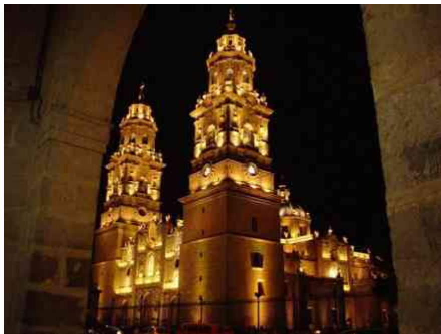
Figura 2.54. Catedral de la ciudad de Morelia antes Valladolid. Estado actual. Foto tomada por Elsa Anaid Aguilar Hernández
