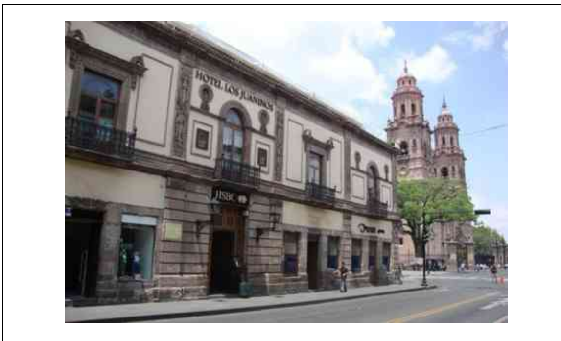
Figura 2.51. Exhospital de San Juan de Dios de Valladolid, estado actual. Foto Elsa Anaid Aguilar Hernández
