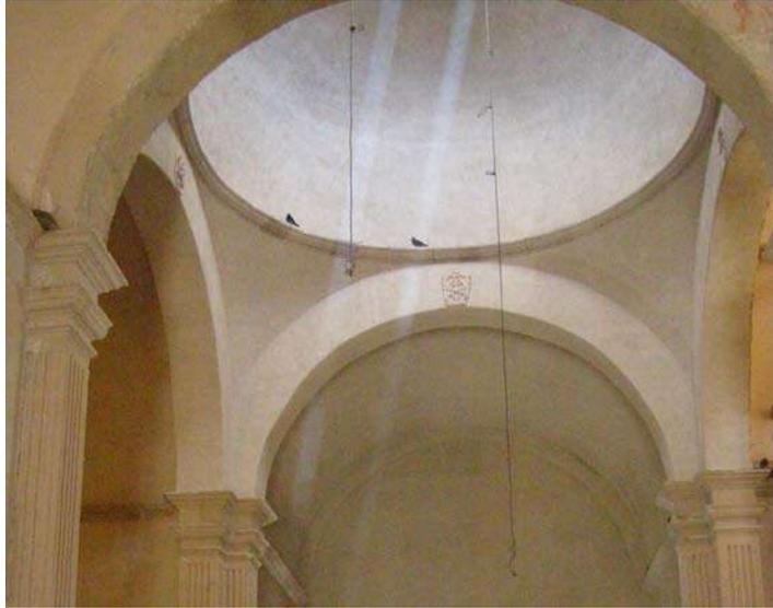
Figura 126. Imagen de los arcos torales, fabricados a partir de mampostería de piedra regular.
