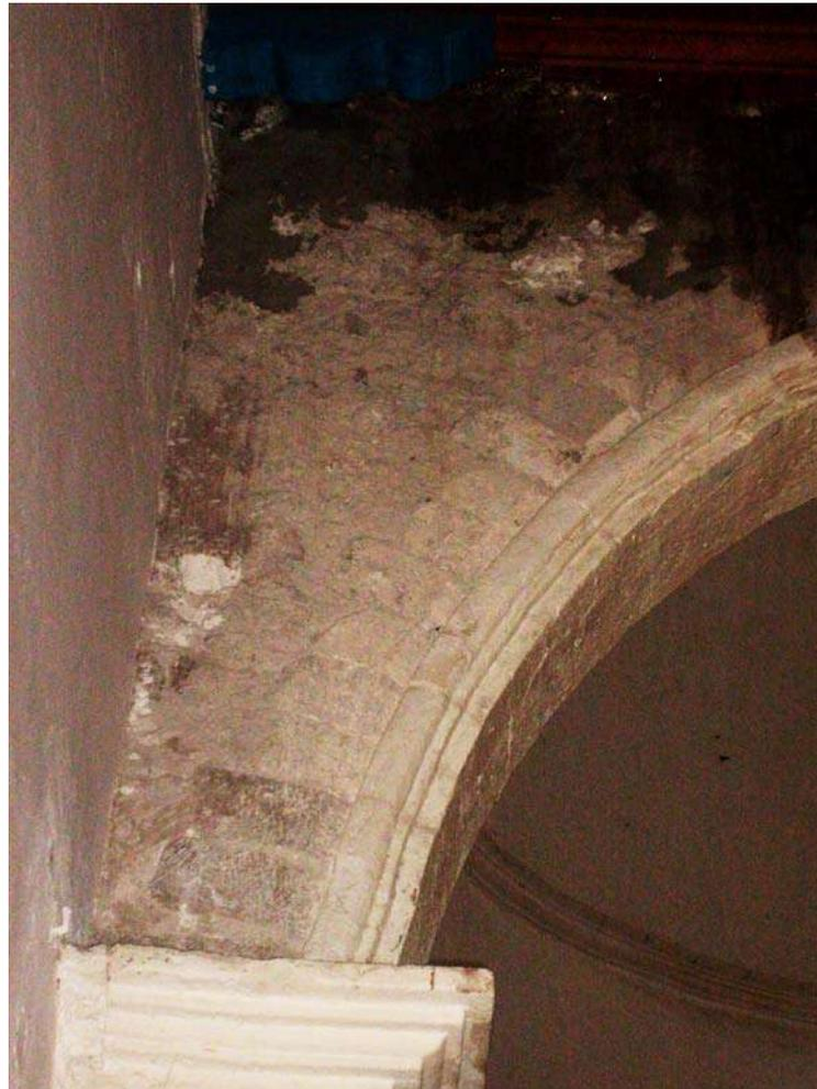
Figura 94. Imagen de la enjuta de un arco toral, donde se aprecia el tamaño de dovelas y la ausencia de salmer. Fuente: Archivo Ramón Holguín
