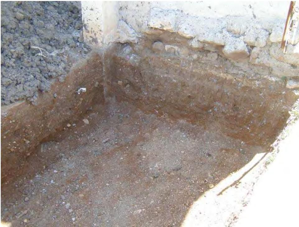
Figura 66. Detalle de la cimentación oeste del templo. Nótese la prolongación del muro, pero cambio de material. Fuente: Archivo Misiones Coloniales de Chihuahua A.C., 2009.
