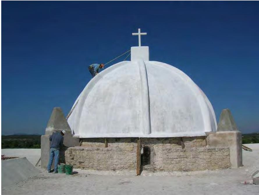
Figura 93. Vista de la cúpula, donde se aprecia el trabajo de cantería semi-labrada a partir de rocas riolíticas irregulares. Fuente: Archivo Ramón Holguín, 2007.
