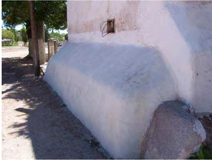
Figura 109. Murete adosado en el perímetro del templo, el cual tiene la función de proteger a los cimientos de la erosión por agua. Fuente: Ramón Holguín, 2009.
