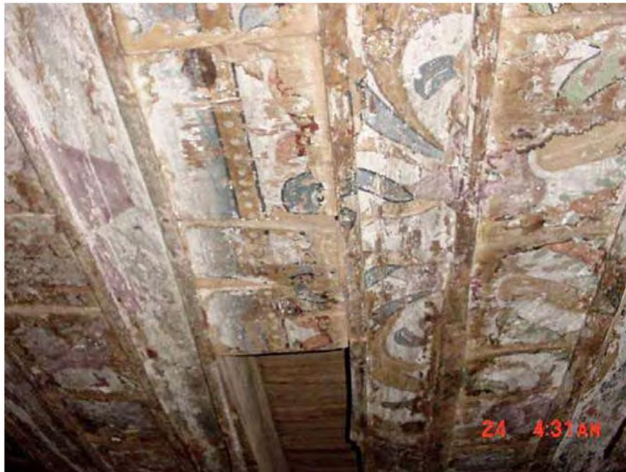
Figura 111. Detalle del entablado superior donde se aprecia la inserción de tabletas en las vigas y su fijado a través de listones. Fuente: Archivo Misiones Coloniales de Chihuahua A.C., 2001.
