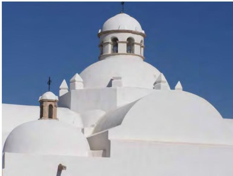
Figura 123. Fotografía del sistema de cúpulas y bóvedas mostrando los accesos de luz al interior a través de barbicanes. Fuente: Ramón Holguín, 2010.
