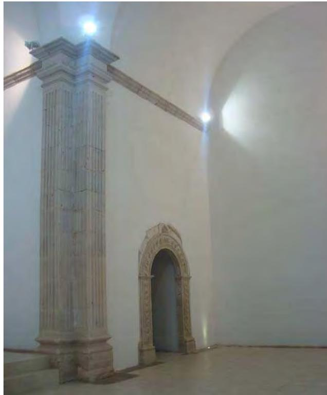
Figura 124. Pilastra toscana que soporta el arco toral norte en el transepto. Obsérvese, el fino trabajo de labrado. Fuente: Ramón Holguín, 2010.
