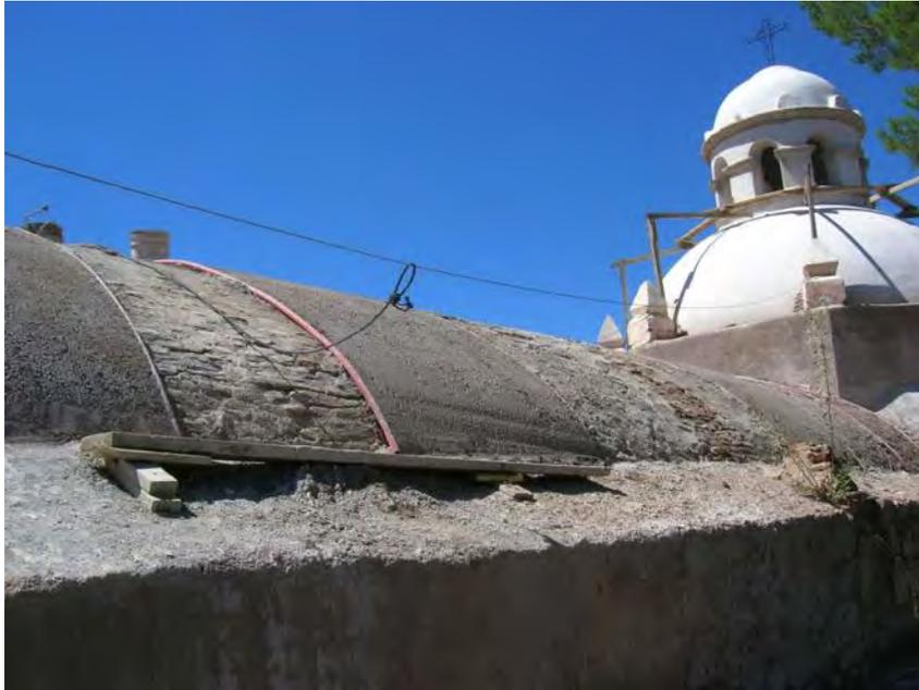
Figura 125. Imagen del sistema constructivo de bóveda. Fuente: Ramón Holguín, 2007.
