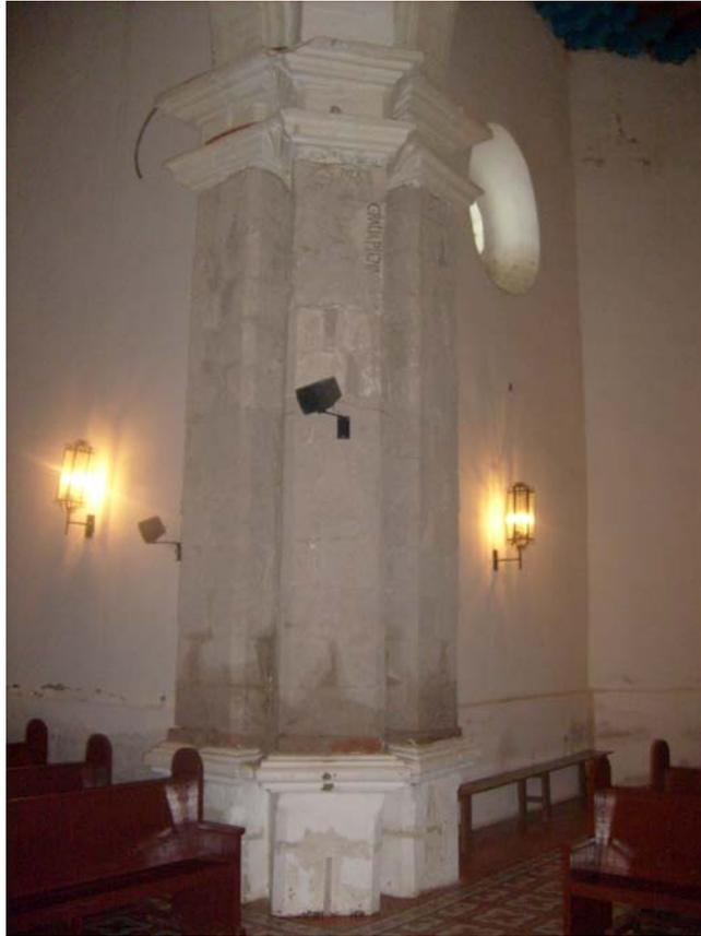
Figura 92. Toma de las pilastras de crucero, donde se aprecia el uso de sillares de cantería. Fuente: Archivo Ramón Holguín, 2010.
