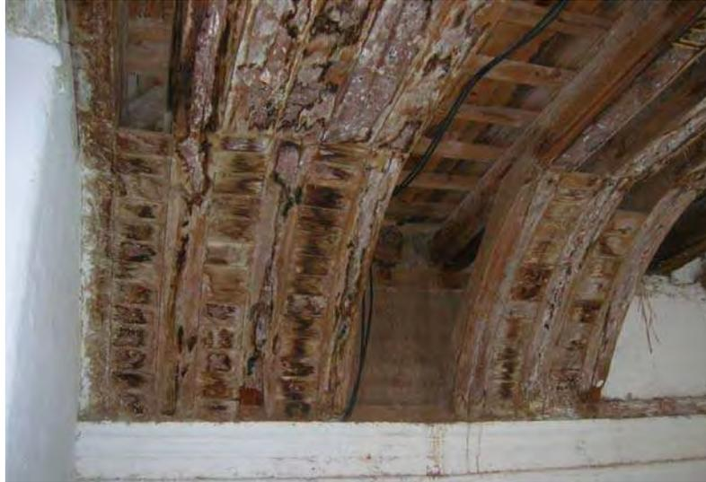
Figura 69. Detalle constructivo de la bóveda deprimida. Fuente: Ramón Holguín.2009
