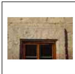
**Fig. 3.107.** Cerramiento exterior, platabanda dovelada en puerta de accesoria de fachada lateral de planta baja, casa de Isidro Huarte.
