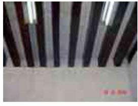
**Sistema constructivo:** Viguería de madera apoyada sobre los muros de carga sobre una viga de arrastre para distribuir la carga, con tapa de ladrillo de barro, recibiendo un terrado de 15 a 30 cm, con un entortado de cemento arena que recibe enladrillado de cubierta.
