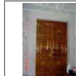
**Sistema constructivo:** Marco para vano de puerta de cantería labrada asentada con mortero de cal-arena, cerramiento al exterior platabanda dovelada, apoyada en jambas empotradas al muro.
