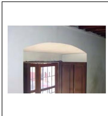
**Fig. 3.90. Cerramiento interior, capialzado escarzano en ventana de fachada principal de planta baja, Palacio Episcopal.**
