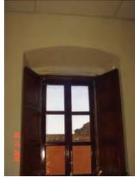
**Sistema constructivo:** Marco para vano de ventana de cantería labrada, asentada con mortero de cal-arena, cerramiento al exterior platabanda dovelada, apoyada en jambas empotradas al muro, el cerramiento al interior es capialzado escarzano de mampostería de piedra de cantería aparejada concéntricamente.
