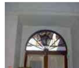
**Sistema constructivo:** Marco para vano de puerta de cantería labrada asentada con mortero de cal-arena, cerramiento al exterior arco peraltado, apoyado en jambas, el cerramiento al interior es capialzado recto de mampostería de piedra de cantería aparejada concéntrica. El peralte del arco lo da un salmer de 10 cm (las jambas no se empotran al muro)
