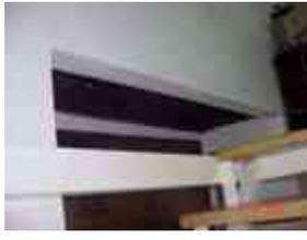
**Sistema constructivo:** Marco para vano de puerta de cantería labrada asentada con mortero de cal-arena, cerramiento al exterior platabanda dovelada, apoyada en jambas empotradas al muro, el cerramiento al interior es dintel de madera.
