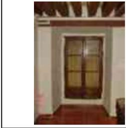
**Sistema constructivo:** Marco para vano de ventana de cantería labrada, asentada con mortero de cal-arena, cerramiento al exterior platabanda dovelada, apoyado en jambas empotradas al muro, el cerramiento al interior es dintel de madera.
