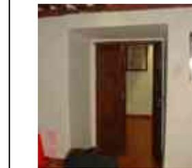
**Sistema constructivo:** Marco para vano de puerta de ladrillo, asentado con mortero de cal-arena, cerramiento al exterior platabanda dovelada, apoyada en jambas empotradas al muro, el cerramiento al interior es capialzado recto de mampostería de piedra de cantería aparejada concéntrica.
