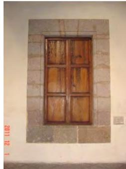
**Sistema constructivo:** Marco para vano de ventana de cantería labrada, asentada con mortero de cal-arena, cerramiento al exterior platabanda dovelada, apoyado en jambas empotradas al muro, el cerramiento al interior es capialzado escarzano de mampostería de piedra de cantería aparejada concéntrica.
