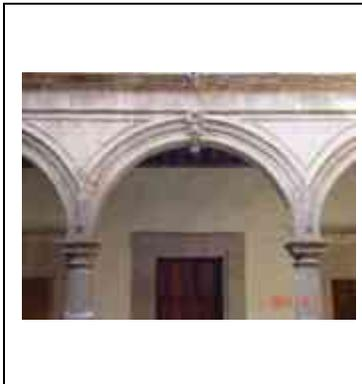
**Fig. 3.122. Arco de medio punto en arquería de planta baja, casa de Isidro Huarte.**
