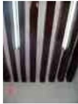
**Sistema constructivo:** Viguería de madera apoyada sobre los muros de carga sobre una viga de arrastre para distribuir la carga, con tapa de ladrillo de barro, recibiendo un terrado de 15 a 30 cm, con un entortado de cemento arena que recibe enladrillado de cubierta.
