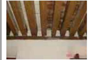
**Sistema constructivo:** Viguería de madera apoyada sobre los muros de carga sobre una viga de arrastre para distribuir la carga, con tapa de ladrillo de barro, recibiendo un terrado de 15 a 30 cm, con un entortado de cemento arena que recibe el piso de entresuelo.
