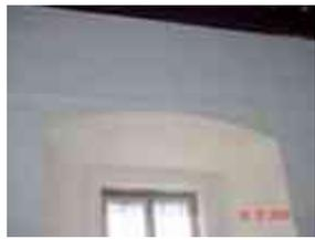
**Sistema constructivo:** Marco para vano de ventana de cantería labrada, asentada con mortero de cal-arena, cerramiento al exterior platabanda dovelada, apoyada en jambas empotradas al muro, el cerramiento al interior es capialzado escarzano de mampostería de piedra de cantería aparejada concéntricamente.
