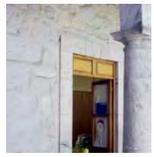
**Sistema constructivo:** Muros de mampostería de piedra irregular de cantería, amarrados entre sí a escuadra, asentados con mortero cal-arena.
