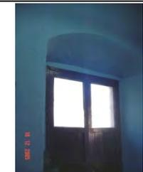
**Sistema constructivo:** Marco para vano de puerta de cantería labrada asentada con mortero de cal-arena, cerramiento al exterior arco escarzano, apoyado en jambas empotradas al muro, al interior es capialzado escarzano de mampostería de piedra de cantería aparejada concéntrica.
