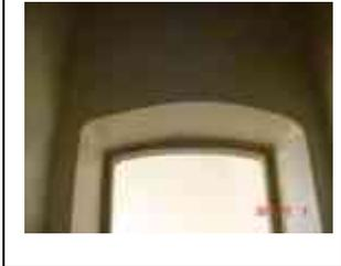
**Sistema constructivo:** Marco para vano de puerta de cantería labrada asentada con mortero de cal-arena, cerramiento al exterior arco escarzano, apoyado en jambas, el cerramiento al interior es capialzado escarzano de mampostería de piedra de cantería aparejada concéntrica.
