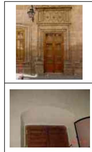
**Sistema constructivo:** Marco para vano de puerta de cantería labrada, asentada con mortero de cal-arena, cerramiento al exterior platabanda dovelada con tapa moldurada, apoyada en jambas empotradas al muro, el cerramiento al interior es capialzado escarzano de mampostería de piedra de cantería aparejada concéntrica.
