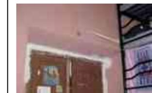
**Sistema constructivo:** Marco para vano de puerta de cantería labrada asentada con mortero de cal-arena, cerramiento al exterior arco escarzano, apoyado en jambas empotradas al muro, al interior es capialzado recto de mampostería de piedra de cantería aparejada concéntrica.
