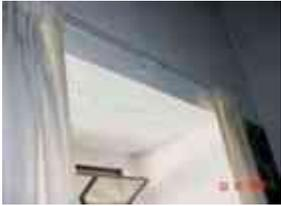
**Sistema constructivo:** El vano de la ventana no cuenta con marco de cantería, el cerramiento al exterior es arco escazano, al interior es dintel de madera.
