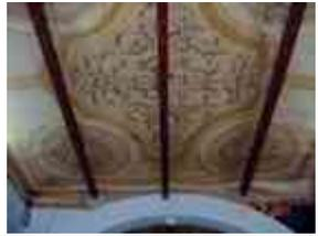
**Sistema constructivo:** Viguera de madera apoyada sobre los muros de carga sobre una viga de arrastre para distribuir la carga, con tapa de tablón de madera, recibiendo un terrado de 15 a 30 cm, con un entortado de cemento arena que recibe el piso de planta alta. El entrepiso cuenta con un plafón de cielo raso decorado.
