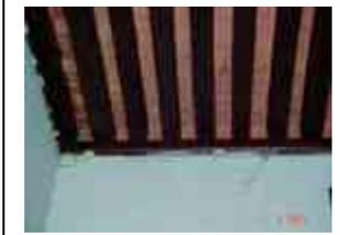
**Sistema constructivo:** Viguera de madera apoyada sobre los muros de carga sobre una viga de arrastre para distribuir la carga, con tapa de ladrillo de barro, recibiendo un terrado de 15 a 30 cm, con un entortado de cemento arena que recibe enladrillado de cubierta.
