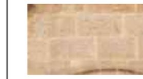
**Sistema constructivo:** Muros de mampostería de piedra irregular de cantería, amarrados entre sí a escuadra, asentados con mortero cal-arena. El muro C de la fachada es mixto, en el exterior sillar de cantería y en el interior mampostería de piedra irregular de cantería, con núcleo o relleno de ripio y mortero de cal.
