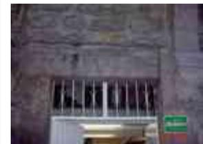
**Sistema constructivo:** Marco para vano de puerta de cantería labrada asentada con mortero de cal-arena, cerramiento al exterior platabanda dovelada, apoyada en jambas empotradas al muro, el cerramiento al interior es capialzado recto de mampostería de piedra de cantería aparejada concéntrica.
