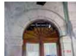
**Sistema constructivo:** Marco para vano de puerta de cantería labrada asentada con mortero de cal-arena, cerramiento al exterior arco peraltado, apoyado en jambas, el cerramiento al interior es capialzado recto de mampostería de piedra de cantería aparejada concéntrica. El peralte del arco lo da un salmer de 10 cm (las jambas no se empotran al muro)
