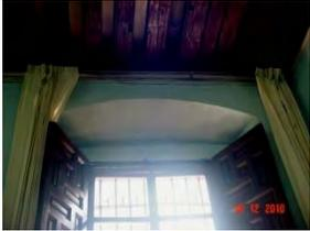
**Sistema constructivo:** Marco para vano de ventana con derrame al interior, de cantería labrada asentada con mortero de cal-arena, cerramiento al exterior platabanda dovelada, apoyada en jambas empotradas al muro, el cerramiento al interior es capialzado recto de mampostería de piedra de cantería aparejada concéntricamente.
