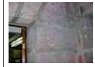
**Sistema constructivo:** El vano de la puerta no cuenta con marco de cantería, se conforma con piedras "echadas" que se enlazan con el muro, el cerramiento al exterior es platabanda dovelada, al interior es capialzado escarzano de mampostería de piedra de cantería aparejada concéntrica.
