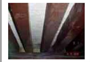
**Sistema constructivo:** Viguería de madera apoyada sobre los muros de carga sobre una viga de arrastre para distribuir la carga, con tapa de ladrillo de barro, recibiendo un terrado de 15 a 30 cm, con un entortado de cemento arena que recibe el piso de planta alta.
