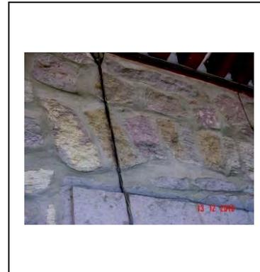
**Fig. 3.152. Arco de descarga sobre platabanda dovelada, cerramiento exterior en vano de puerta Palacio Episcopal.**
