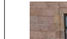
**Sistema constructivo:** Muros de mampostería de piedra irregular de cantería, amarrados entre sí a escuadra, asentados con mortero cal-arena.
