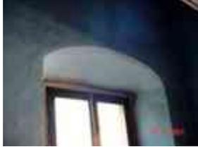
**Sistema constructivo:** Marco para vano de ventana de cantería labrada, asentada con mortero de cal-arena, cerramiento al exterior arco escarzano, apoyado en jambas empotradas al muro, el cerramiento al interior es capialzado escarzano de mampostería de piedra de cantería aparejada concéntrica.
