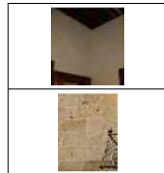
**Sistema constructivo:** Muros de mampostería de piedra irregular de cantería, amarrados entre sí a escuadra, asentados con mortero cal-arena. El muro C de la fachada es mixto, en el exterior sillar de cantería y en el interior mampostería de piedra irregular de cantería, con núcleo o relleno de ripio y mortero de cal.
