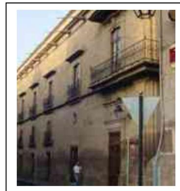
**Fig. 3.55. Paramentos de sillería a plomo, en fachada lateral, casa de Isidro Huarte.**
