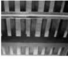
**Sistema constructivo:** Viguería de madera apoyada sobre los muros de carga sobre una viga de arrastre para distribuir la carga, con tapa de ladrillo de barro, recibiendo un terrado de 15 a 30 cm, con un entortado de cemento arena que recibe el piso de planta alta.
