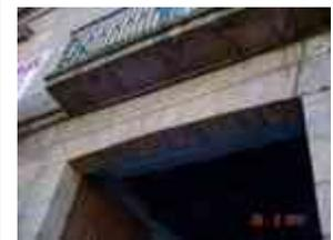
**Sistema constructivo:** Marco para vano de puerta de cantería labrada asentada con mortero de cal-arena, cerramiento al exterior arco escarzano, apoyado en jambas empotradas al muro, al interior es capialzado recto de mampostería de piedra de cantería aparejada concéntricamente.
