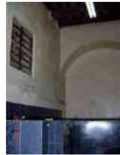
**Sistema constructivo:** Muros de mampostería de piedra irregular de cantería, amarrados entre sí a escuadra, asentados con mortero cal-arena.
