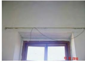
**Sistema constructivo:** El vano de la ventana no cuenta con marco de cantería, el cerramiento al interior es dintel de madera.
