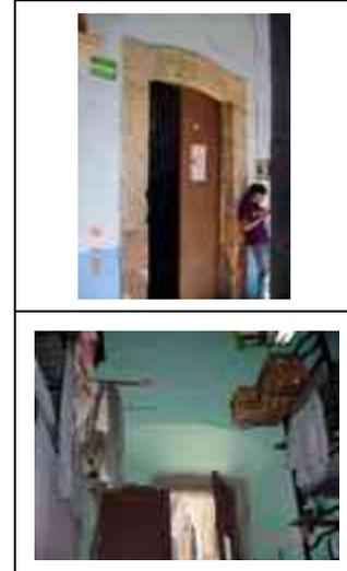
**Sistema constructivo:** Marco para vano de puerta de cantería labrada asentada con mortero de cal-arena, cerramiento al exterior arco escarzano, apoyado en jambas empotradas al muro, al interior es capialzado escarzano de mampostería de piedra de cantería aparejada concéntrica.
