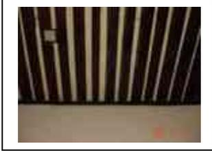
**Sistema constructivo:** Viguería de madera apoyada sobre los muros de carga sobre una viga de arrastre para distribuir la carga, con tapa de ladrillo de barro, recibiendo un terrado de 15 a 30 cm, con un entortado de cemento arena que recibe el enladrillado de azotea.
