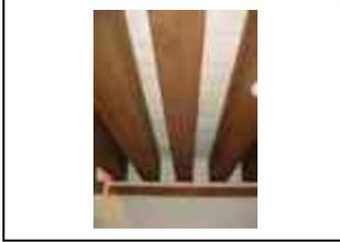
**Sistema constructivo:** Viguera de madera apoyada sobre los muros de carga sobre una viga de arrastre para distribuir la carga, con tapa de ladrillo de barro, recibiendo un terrado de 15 a 30 cm, con un entortado de cemento arena que recibe el piso de planta alta.
