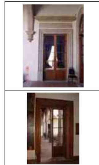
**Sistema constructivo:** Marco para vano de puerta de cantería labrada, asentada con mortero de cal-arena, cerramiento al exterior platabanda dovelada, apoyada en jambas, empotradas al muro, el cerramiento al interior es capialzado recto de mampostería de piedra de cantería aparejada concéntrica.
