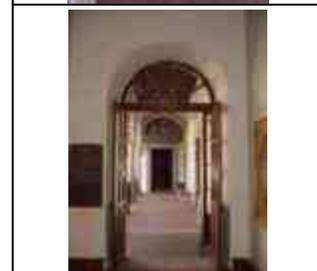
**Sistema constructivo:** Marco para vano de puerta de cantería labrada asentada con mortero de cal-arena, cerramiento al exterior arco de medio punto, apoyado en jambas, el cerramiento al interior es el intradós del arco de mampostería de piedra de cantería aparejada concéntricamente.
