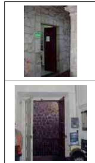
**Sistema constructivo:** Marco para vano de puerta de cantería labrada asentada con mortero de cal-arena, cerramiento al exterior platabanda dovelada, apoyada en jambas empotradas al muro, el cerramiento al interior es capialzado recto de mampostería de piedra de cantería aparejada concéntrica.
