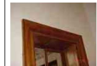
**Sistema constructivo:** Marco para vano de puerta de cantería labrada, asentada con mortero de cal-arena, cerramiento al exterior platabanda dovelada, apoyada en jambas, empotradas al muro, el cerramiento al interior es capialzado recto de mampostería de piedra de cantería aparejada concéntrica.
