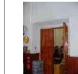
**Sistema constructivo:** Marco para vano de puerta de cantería labrada asentada con mortero de cal-arena, cerramiento al exterior platabanda dovelada, apoyada en jambas empotradas al muro, el cerramiento al interior es capialzado recto de mampostería de piedra de cantería aparejada concéntrica.
