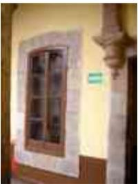
**Sistema constructivo:** Marco para vano de ventana de cantería labrada, asentada con mortero de cal-arena, cerramiento al exterior arco escarzano, apoyado en jambas empotradas al muro, el cerramiento al interior es capialzado recto de mampostería de piedra de cantería aparejada concéntricamente.
