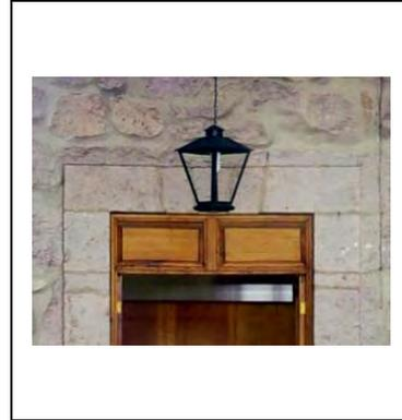
**Fig. 3.98. Cerramiento exterior, platabanda en puerta interior de planta alta, Palacio Episcopal.**
