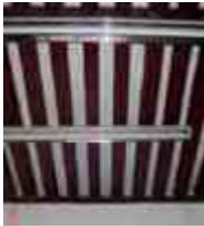
**Sistema constructivo:** Viguería de madera apoyada sobre los muros de carga sobre una viga de arrastre para distribuir la carga, con tapa de ladrillo de barro, recibiendo un terrado de 15 a 30 cm, con un entortado de cemento arena que recibe enladrillado de cubierta.
