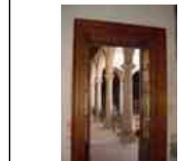
**Sistema constructivo:** Marco para vano de puerta de cantería labrada, asentada con mortero de cal-arena, cerramiento al exterior platabanda dovelada, apoyada en jambas, empotradas al muro, el cerramiento al interior es capialzado recto de mampostería de piedra de cantería aparejada concéntrica.
