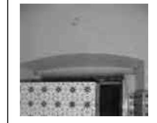
**Sistema constructivo:** Marco para vano de puerta de cantería labrada asentada con mortero de cal-arena, cerramiento al exterior platabanda dovelada, apoyada en jambas empotradas al muro, el cerramiento al interior es capialzado escarzano de mampostería de piedra de cantería aparejada concéntrica.
