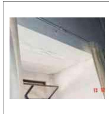
**Fig. 3.101. Cerramiento interior, con dinteles de madera, en ventanas de crujía norte de planta alta que colindan con el Centro de Salud, Palacio Episcopal.**
