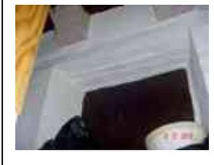
**Sistema constructivo:** Marco para vano de ventana con derrame al interior, de cantería labrada asentada con mortero de cal-arena, cerramiento al exterior platabanda dovelada, apoyada en jambas empotradas al muro, el cerramiento al interior es capialzado recto de mampostería de piedra de cantería aparejada concéntrica.
