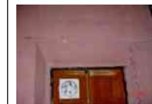
**Sistema constructivo:** Marco para vano de puerta de cantería labrada asentada con mortero de cal-arena, cerramiento al exterior arco escarzano, apoyado en jambas empotradas al muro, al interior es capialzado recto de mampostería de piedra de cantería aparejada concéntrica.
