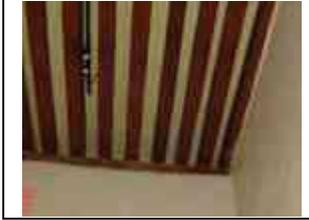
**Sistema constructivo:** Viguera de madera apoyada sobre los muros de carga sobre una viga de arrastre para distribuir la carga, con tapa de ladrillo de barro, recibiendo un terrado de 15 a 30 cm, con un entortado de cemento arena que recibe el enladrillado de azotea.
