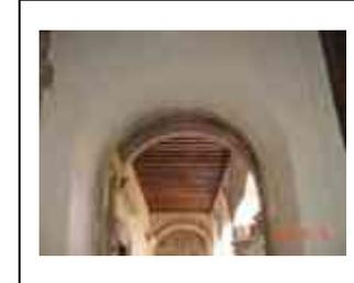
**Sistema constructivo:** Marco para vano de puerta de cantería labrada asentada con mortero de cal-arena, cerramiento al exterior arco de medio punto, apoyado en jambas, el cerramiento al interior es el intradós del arco de mampostería de piedra de cantería aparejada concéntrica.
