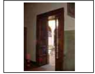
**Sistema constructivo:** Marco para vano de puerta de cantería labrada, asentada con mortero de cal-arena, cerramiento al exterior platabanda dovelada, apoyada en jambas, empotradas al muro, el cerramiento al interior es capialzado recto de mampostería de piedra de cantería aparejada concéntrica.
