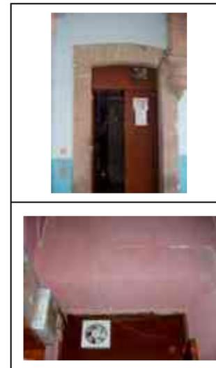
**Sistema constructivo:** Marco para vano de puerta de cantería labrada asentada con mortero de cal-arena, cerramiento al exterior arco escarzano, apoyado en jambas empotradas al muro, al interior es capialzado recto de mampostería de piedra de cantería aparejada concéntrica. La puerta denota en su marco de cantería que no es original.
