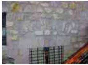
**Sistema constructivo:** Vano forjado sin marco de cantería, solo piedras horizontales (echados) empotrados al muro, con un cerramiento exterior que es platabanda dovelada, el cerramiento al interior es capialzado recto de mampostería de piedra de cantería aparejada concéntricamente. El vano cuenta con arco de descarga
