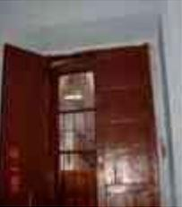
**Sistema constructivo:** Marco para vano de ventana de cantería labrada, asentada con mortero de cal-arena, cerramiento al exterior arco escarzano, apoyado en jambas empotradas al muro, el cerramiento al interior es capialzado recto de mampostería de piedra de cantería aparejada concéntricamente.
