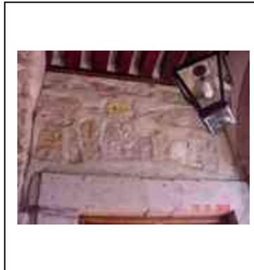
**Fig. 3.151 Arco de descarga sobre platabanda dovelada, cerramiento exterior en vano de puerta Palacio Episcopal.**
