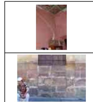
**Sistema constructivo:** Muros de mampostería de piedra irregular de cantería, amarrados entre sí a escuadra, asentados con mortero cal-arena. El muro C de la fachada es mixto, en el exterior sillar de cantería y en el interior mampostería de piedra irregular de cantería, con núcleo o relleno de ripio y mortero de cal. Los muros B y D, son contemporáneos de mampostería de tabique de barro rojo.
