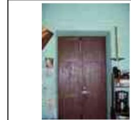
**Sistema constructivo:** El vano de la puerta carece de marco de cantería labrada, cuenta con un marco de madera completo, con jambas y cerramiento recto, el cerramiento interior es dintel de concreto. Lo anterior denota que el vano no es original.
