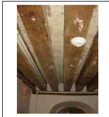
**Fig. 3.201. Viguería con tapa de ladrillo de barro en cubierta de entresuelo, casa de Isidro Huarte.**
