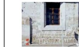
**Sistema constructivo:** Muros de mampostería de piedra irregular de cantería, amarrados entre sí a escuadra, asentados con mortero cal-arena.
