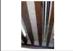
**Sistema constructivo:** Viguería de madera apoyada sobre los muros de carga sobre una viga de arrastre para distribuir la carga, con tapa de tablón de madera, recibiendo un terrado de 15 a 30 cm, con un entortado de cemento arena que recibe el piso de planta alta.
