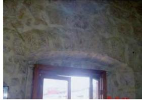
**Sistema constructivo:** Marco para vano de ventana con derrame al interior, de cantería labrada asentada con mortero de cal-arena, cerramiento al exterior platabanda dovelada, apoyada en jambas empotradas al muro, el cerramiento al interior es capialzado escarzano de mampostería de piedra de cantería aparejada concéntrica.
