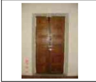
**Sistema constructivo:** Marco para vano de puerta de cantería labrada, asentada con mortero de cal-arena, cerramiento al exterior platabanda dovelada, apoyada en jambas empotradas al muro, el cerramiento al interior es capialzado recto de mampostería de piedra de cantería aparejada concéntrica.
