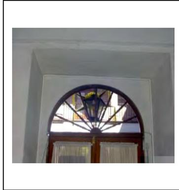
**Fig. 3.97. Cerramiento interior, Capialzado recto, en puerta interior de planta baja, Palacio Episcopal.**
