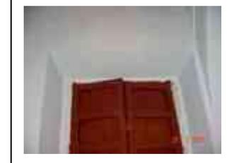
**Sistema constructivo:** Marco para vano de puerta de cantería labrada asentada con mortero de cal-arena, cerramiento al exterior arco escarzano, apoyado en jambas empotradas al muro, al interior es capialzado recto de mampostería de piedra de cantería aparejada concéntrica.
