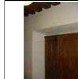
**Sistema constructivo:** Marco para vano de puerta de cantería labrada, asentada con mortero de cal-arena, cerramiento al exterior platabanda dovelada, apoyada en jambas empotradas al muro, el cerramiento al interior es capialzado recto de mampostería de piedra de cantería aparejada concéntrica.
