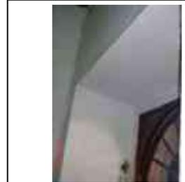
**Sistema constructivo:** Marco para vano de puerta de cantería labrada asentada con mortero de cal-arena, cerramiento al exterior arco peraltado, apoyado en jambas, el cerramiento al interior es capialzado recto de mampostería de piedra de cantería aparejada concéntrica. El peralte del arco lo da un salmer de 10 cm (las jambas no se empotran al muro)
