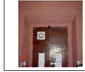
**Sistema constructivo:** Marco para vano de puerta de cantería labrada asentada con mortero de cal-arena, cerramiento al exterior arco escarzano, apoyado en jambas empotradas al muro, al interior es capialzado recto de mampostería de piedra de cantería aparejada concéntricamente.
