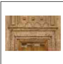
**Fig. 3.106.** Cerramiento exterior, platabanda dovelada en puerta de accesoria de fachada principal de planta baja, casa de Isidro Huarte.
