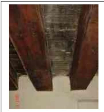
**Fig. 3.200. Viguería con tapa de tablón de madera en entresuelo de pasillo que conduce al 2do. patio, planta baja, casa de Isidro Huarte.**
