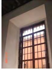
**Sistema constructivo:** Marco para vano de ventana con derrame al interior, de cantería labrada asentada con mortero de cal-arena, cerramiento al exterior platabanda dovelada, apoyada en jambas empotradas al muro, el cerramiento al interior es capialzado recto de mampostería de piedra de cantería aparejada concéntrica.
