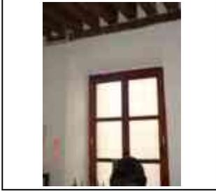
**Sistema constructivo:** Marco para vano de ventana de cantería labrada, asentada con mortero de cal-arena, cerramiento al exterior platabanda dovelada, apoyado en jambas empotradas al muro, el cerramiento al interior es capialzado recto de mampostería de piedra de cantería aparejada concéntrica.
