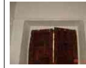
**Sistema constructivo:** Marco para vano de puerta de cantería labrada, asentada con mortero de cal-arena, cerramiento al exterior platabanda dovelada con tapa moldurada, apoyada en jambas empotradas al muro, el cerramiento al interior es dintel de madera.
