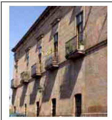
**Fig. 3.53. Paramento de sillería a plomo en fachada lateral, casa del cura Juan Bruno de Luna.**
