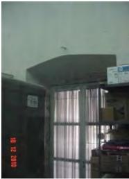
**Sistema constructivo:** El vano de la ventana no cuenta con marco de cantería, se conforma con piedras "echadas" que se enlazan con el muro, el cerramiento al exterior es platabanda dovelada con arco de descarga, al interior es capialzado escarzano de mampostería de piedra de cantería aparejada concéntricamente.
