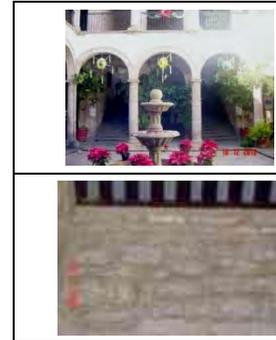
**Sistema constructivo:** Muros de mampostería de piedra irregular de cantería, amarrados entre sí a escuadra, asentados con mortero cal-arena.
