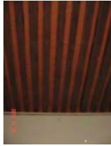
**Sistema constructivo:** Viguería de madera apoyada sobre los muros de carga sobre una viga de arrastre para distribuir la carga, con tapa de ladrillo de barro, recibiendo un terrado de 15 a 30 cm, con un entortado de cemento arena que recibe el piso de planta alta.
