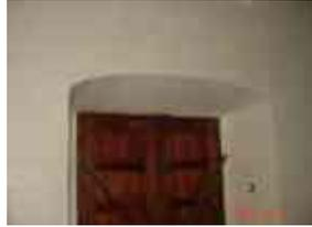
**Sistema constructivo:** Marco para vano de puerta de cantería labrada, asentada con mortero de cal-arena, cerramiento al exterior platabanda dovelada, apoyado en jambas empotradas al muro, el cerramiento al interior es capialzado escarzano de mampostería de piedra de cantería aparejada concéntrica.
