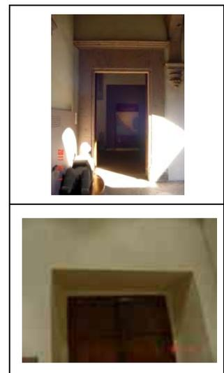
**Sistema constructivo:** Marco para vano de puerta de cantería labrada, asentada con mortero de cal-arena, cerramiento al exterior platabanda dovelada con tapa moldurada, apoyada en jambas empotradas al muro, el cerramiento al interior es capialzado recto de mampostería de piedra de cantería aparejada concéntrica.
