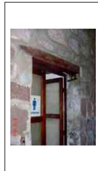
**Sistema constructivo:** El vano de la puerta no cuenta con marco de cantería, se conforma con piedras "echadas" que se enlazan con el muro, el cerramiento al exterior es dintel de madera.
