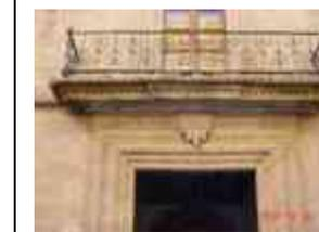
**Sistema constructivo:** Marco para vano de puerta de cantería labrada, asentada con mortero de cal-arena, cerramiento al exterior platabanda dovelada con tapa moldurada, apoyada en jambas empotradas al muro, el cerramiento al interior es capialzado recto de mampostería de piedra de cantería aparejada concéntrica.
