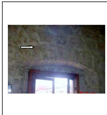
**Fig. 3.43. Capialzado de piedra de cantería aparejada concéntricamente, que enlaza a los dos paramentos del muro, Palacio Episcopal.**
