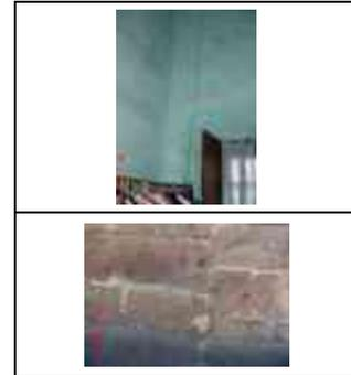
**Sistema constructivo:** Muros de mampostería de piedra irregular de cantería, amarrados entre sí a escuadra, asentados con mortero cal-arena. El muro C de la fachada es mixto, en el exterior sillar de cantería y en el interior mampostería de piedra irregular de cantería, con núcleo o relleno de ripio y mortero de cal. El muros B, es contemporáneo de mampostería de cantería.
