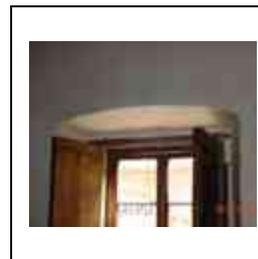
**Fig. 3.108.** Cerramiento interior, capialzado escarzano en puerta de accesoria de fachadas de planta baja, casa de Isidro Huarte.
