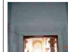
**Sistema constructivo:** Marco para vano de puerta de cantería labrada asentada con mortero de cal-arena, cerramiento al exterior arco escarzano, apoyado en jambas empotradas al muro, al interior es capialzado recto de mampostería de piedra de cantería aparejada concéntricamente.
