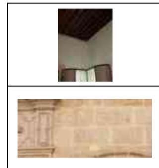
**Sistema constructivo:** Muros de mampostería de piedra irregular de cantería, amarrados entre sí a escuadra, asentados con mortero cal-arena. Los muros B y C de las fachadas son mixtos, en el exterior sillar de cantería y en el interior mampostería de piedra irregular de cantería, con núcleo o relleno de ripio y mortero de cal.
