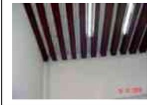
**Sistema constructivo:** Viguería de madera apoyada sobre los muros de carga sobre una viga de arrastre para distribuir la carga, con tapa de ladrillo de barro, recibiendo un terrado de 15 a 30 cm, con un entortado de cemento arena que recibe enladrillado de cubierta.
