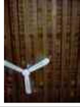
**Sistema constructivo:** Viguería de madera apoyada sobre los muros de carga sobre una viga de arrastre para distribuir la carga, con tapa de ladrillo de barro rojo, recibiendo un terrado de 15 a 30 cm, con un entortado de cemento arena que recibe el piso de planta alta.
