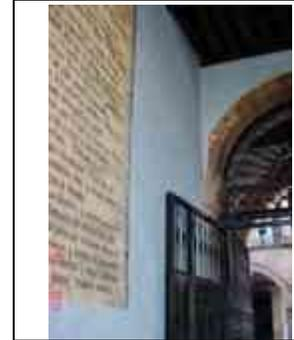
**Sistema constructivo:** Muros de mampostería de piedra irregular de cantería, amarrados entre sí a escuadra, asentados con mortero cal-arena.
