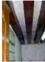
**Sistema constructivo:** Viguería de madera apoyada sobre los muros de carga sobre una viga de arrastre para distribuir la carga, con tapa de tejamanil, recibiendo un terrado de 15 a 30 cm, con un entortado de cemento arena que recibe el piso de planta alta.
