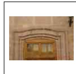
**Fig. 3.109.** Cerramiento exterior, arco escarzano en ventana de accesoria de fachada principal de planta baja, casa de Isidro Huarte.
