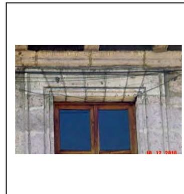
**Fig. 3.91. Cerramiento exterior, platabanda en ventana de fachada principal de planta alta, Palacio Episcopal.**
