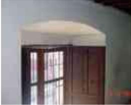
**Sistema constructivo:** Marco para vano de ventana con derrame al interior, de cantería labrada asentada con mortero de cal-arena, cerramiento al exterior platabanda dovelada, apoyada en jambas empotradas al muro, el cerramiento al interior es capialzado recto de mampostería de piedra de cantería aparejada concéntrica.
