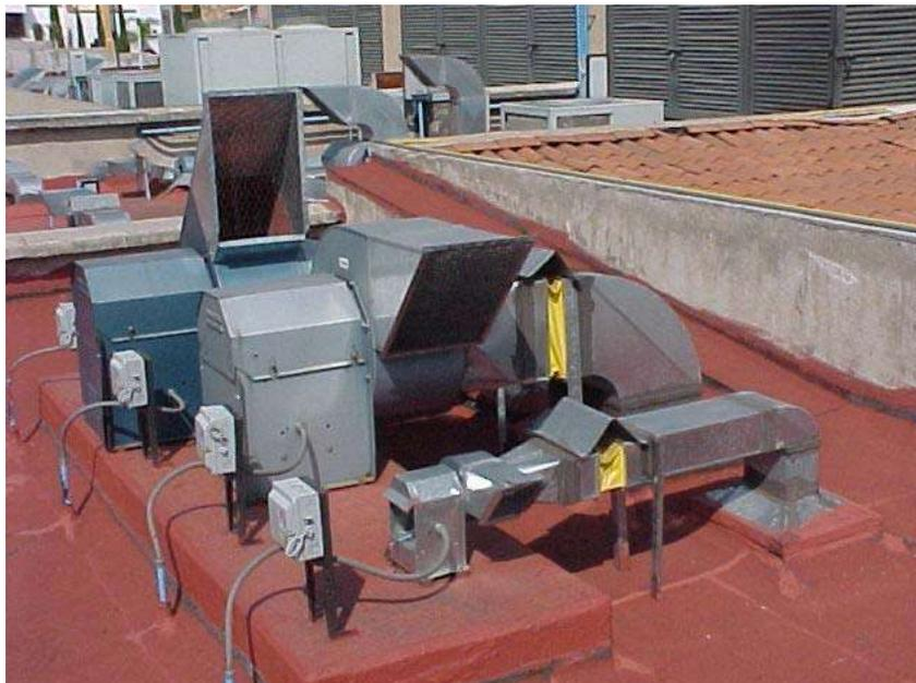
Fig.1.5.- Equipos para extracción de aire
