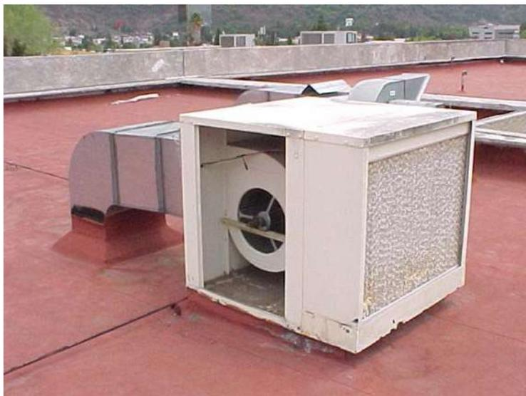
Fig. 1.9.- Unidad lavadora de aire a base de agua.
