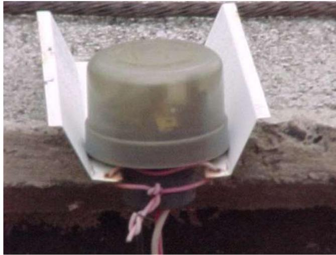
Fig. 2.4.- Fotocelda para las luces de obstrucción del Hospital de la Mujer.
