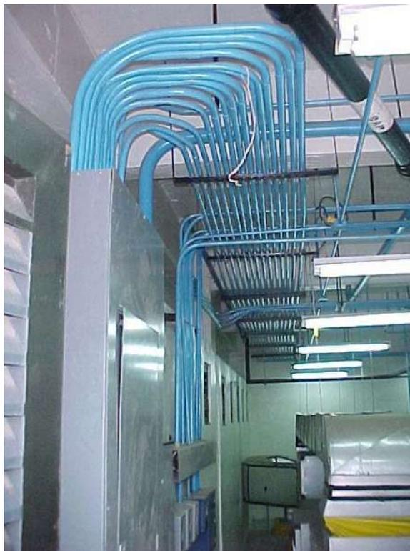
Fig. 1.16.- Tablero y tubos conduit donde se alojan algunos circuitos.
