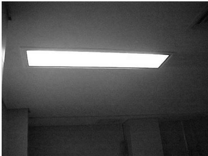
Fig. 2.1.- Luminaria con lámparas fluorescentes T-8 de 2x32W
