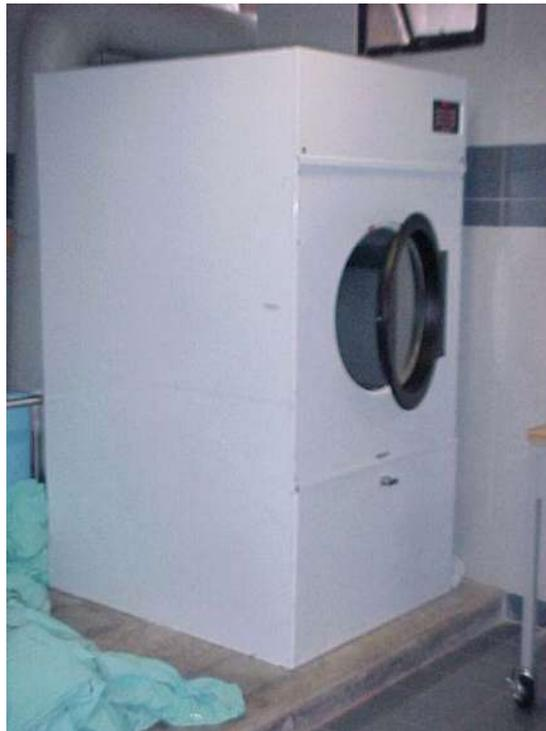
Fig. 1.15.- Secadora alimentada con gas L.P.
