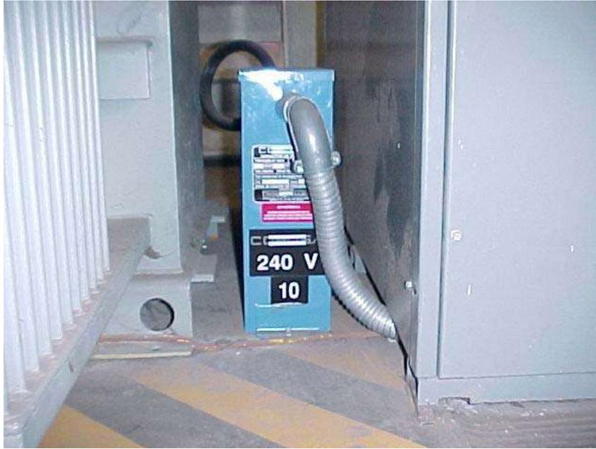
Fig. 2.11.- Banco de capacitores instalado en el Hospital de la Mujer
