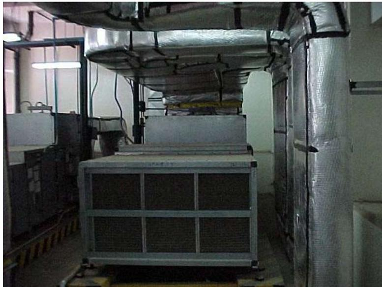
Fig.1.4.- Equipo de aire acondicionado (UMA)
