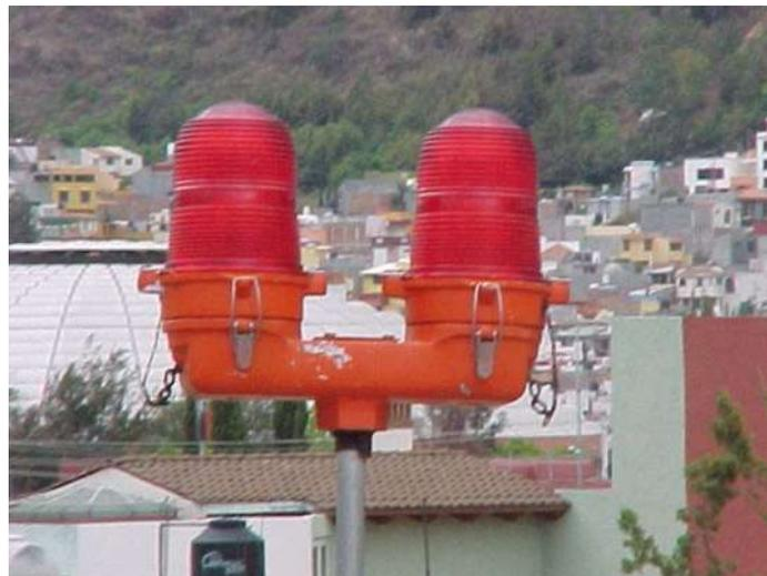
Fig. 2.5.- Luces de obstrucción para el tráfico aéreo del Hospital de la Mujer.
