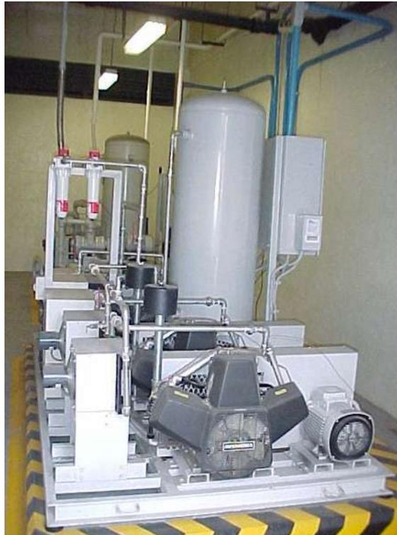
Fig. 1.10.- Equipo de compresión de aire
