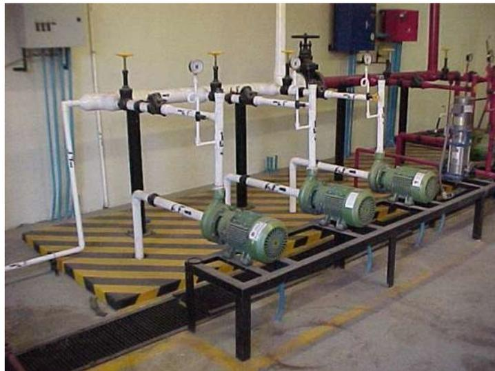
Fig. 1.11.- Sistema hidroneumático.
