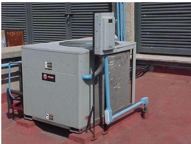
Fig.1.8.- Unidad condensadora
