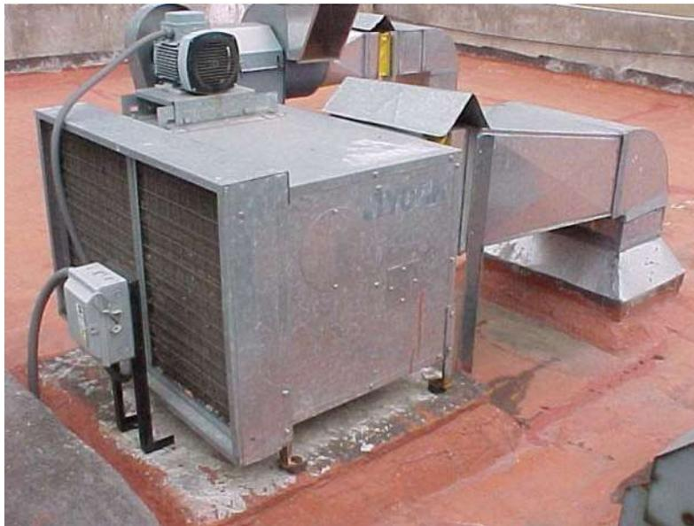
Fig 1.7.- Ventilador de inyección.
