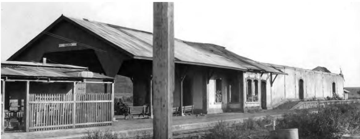
Fig. III.73: Frente y lado oriente del edificio de tabique y lámina (en ruinas) para oficina de la estación con cobertizo de madera y lámina para andén. Tingüindín, 1929.
