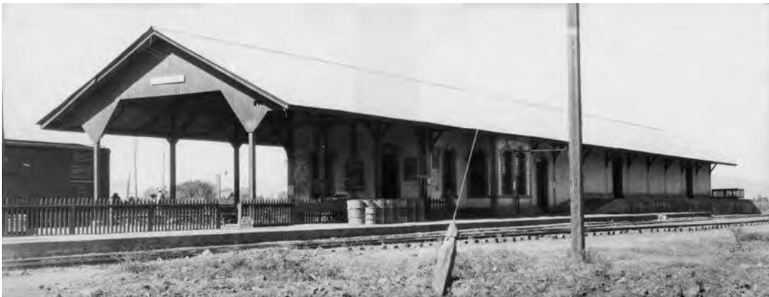
Fig. III.44: Frente y lado sur del edificio de adobe, tabique y lámina para oficina de la estación y bodega de carga, con andén de fierro, madera y lámina para pasajeros, en extremo sur. Zamora. 1929.
