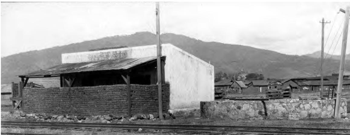
Fig. III.66: Casa de adobe y lámina con cobertizo de madera y lámina para habitación de veladores del patio y de la locomotora. Noria revestida de mampostería con motor y bomba eléctrica para agua, al sur del tinaco. Los Reyes, 1929.
