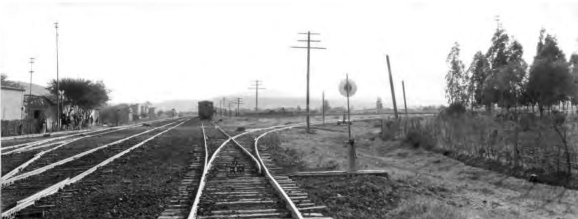
Fig. I.14: Detalle de vía en el empalme de la línea a Los Reyes (en curva a la derecha). Con un ladero del patio de Yurécuaro, Troncal en tangente a la izquierda, 1929.
