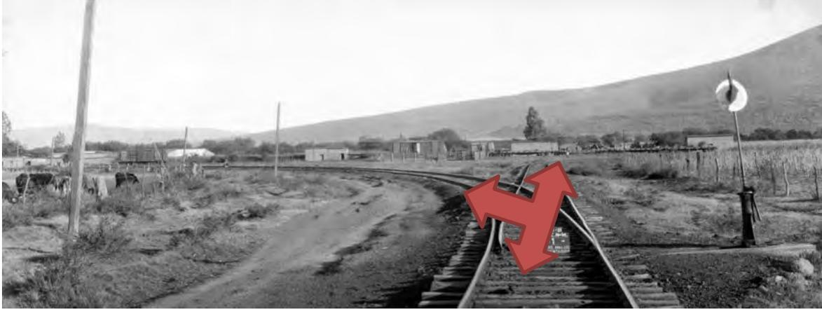
Fig. III.29: Detalle de vía en el empalme de la rama sur de la "Y" (a la derecha) con la línea a Los Reyes (en curva a la izquierda), que también se usa como rama norte de la "Y". 1929.
