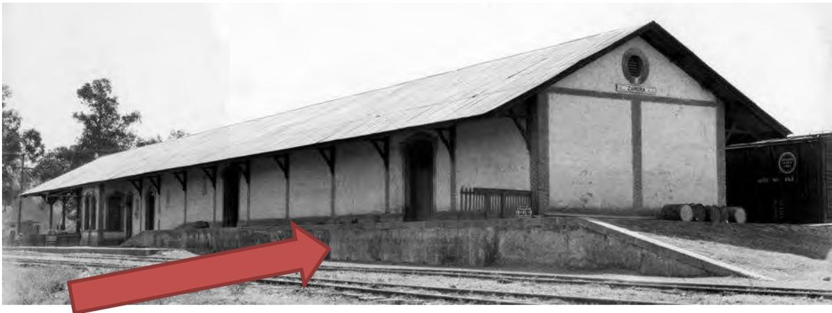
Fig. III.28: Frente y lado norte del edificio de madera, tabique y lámina para oficina de la estación y bodega de carga en Zamora. 1929.
