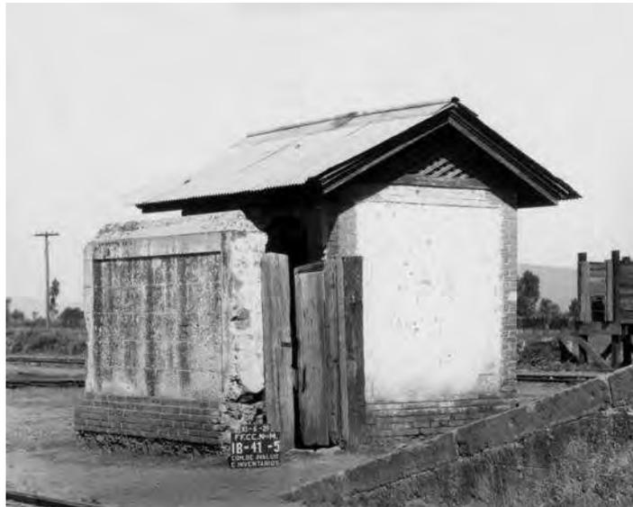
Fig. III.48: Caseta de adobe, tabique y lámina para w. c., anexo a la estación Zamora. 1929.
