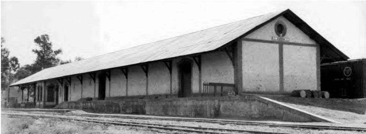
Fig. III.23: Frente y lado sur del edificio de adobe, tabique y lámina para oficina de la estación y bodega de carga en Zamora. 1929.
