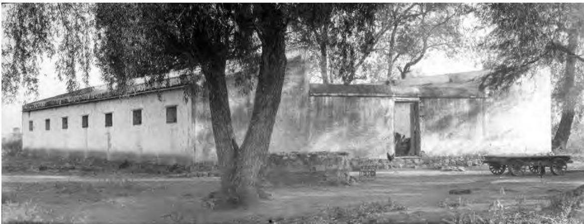
Fig. III.47: Casa de mampostería y lámina para la sección número 3 (vista exterior por el lado de las habitaciones), como a 500 metros al sur de Zamora. 1929.
