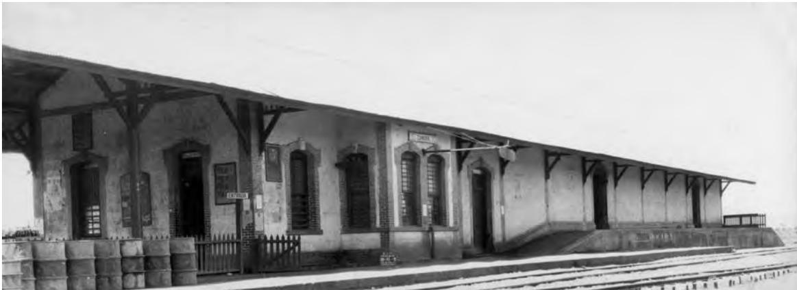
Fig. III.46: Frente y lado sur del edificio de adobe, tabique y lámina para oficina de la estación y bodega de carga en Zamora. 1929.
