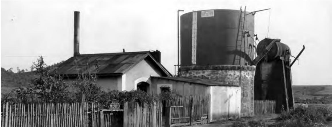
Fig. III.74: Casa de adobe y lámina para caldera. Caseta de adobe y lámina para habitación del bombero. Tinaco para agua de fierro cilíndrico vertical sobre mampostería circular. Tanque para entrega de aceite de fierro cilíndrico horizontal, sobre muros de mampostería. Tingüindín. 1929. Fuente: Biblioteca: CONACULTA/CNPPCF/MNFM/CEDIF. Fondo Comisión de Avalúo e Inventarios. Fototeca.
