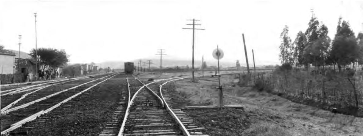
Fig. III.64: Detalle de vía en el empalme de la línea a Los Reyes (en curva a la derecha). Con un ladero del patio de Yurécuaro. Troncal en tangente a la izquierda. 1929.
